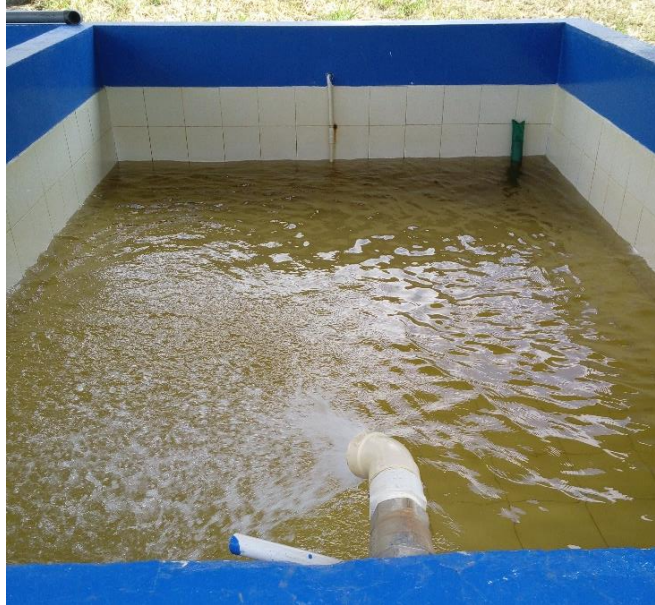
Figura 9. Fotografía sistema de ingreso y salida de agua en los estanques.
