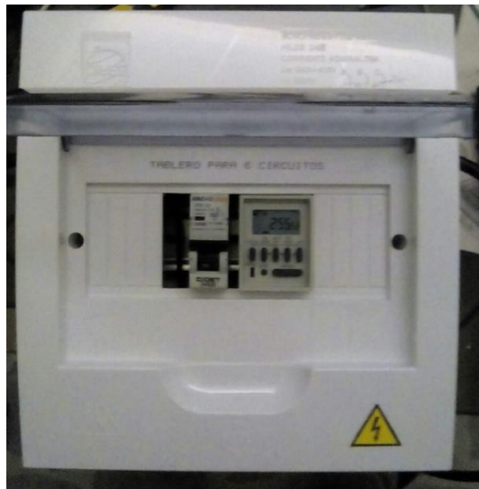
Figura 18. Caja de control para el temporizador TM-848-1
