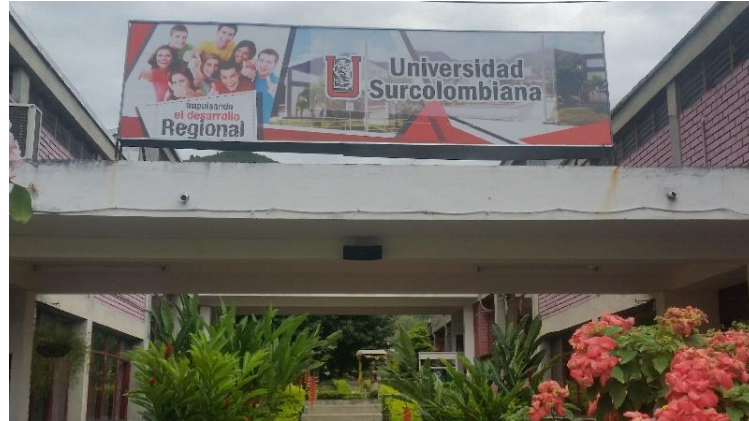
Figura 64. Modulo en los sectores del pasillo, auditorio y cafetería.
