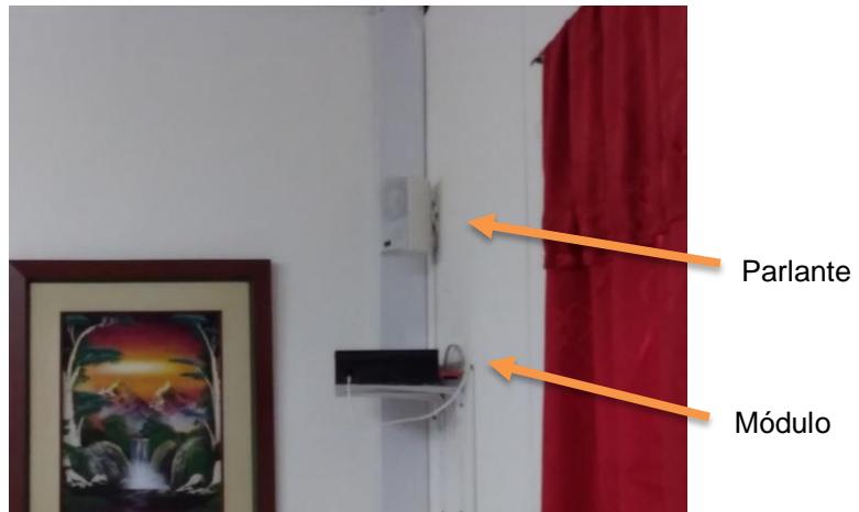
Figura 68. Módulo en sectores de oficina y hall en 1er y 2do piso
