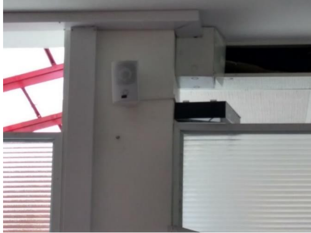
Figura 67. Módulo en los sectores de coordinación, pasillo y secretaría
