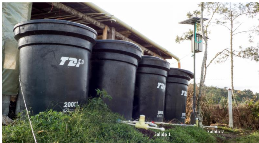
Figura 4. Arreglo de tanques de riego y salidas
