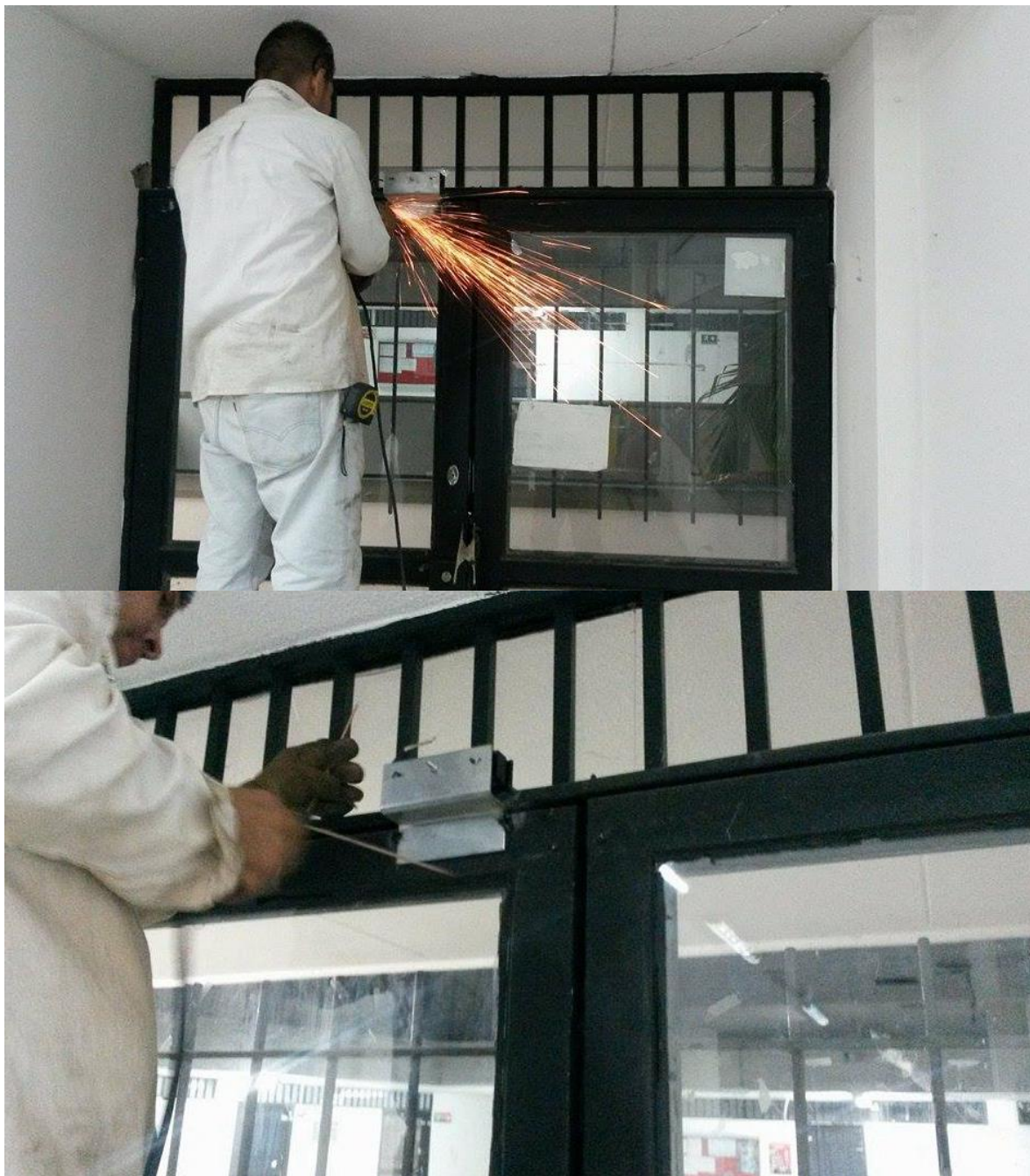
Figura 37. Instalación y adecuación. Fuente. Elaboración propia.
