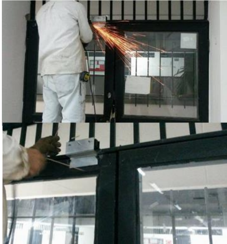
Figura 25. Instalación de los elementos control acceso. Fuente. Elaboración propia.
