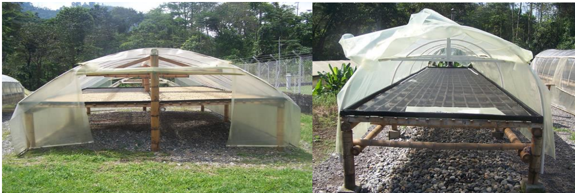
Figura 4. Estructura de Secador Parabólico. En “Beneficio del café en Colombia” por Federación nacional de cafeteros en Colombia, 2015.
