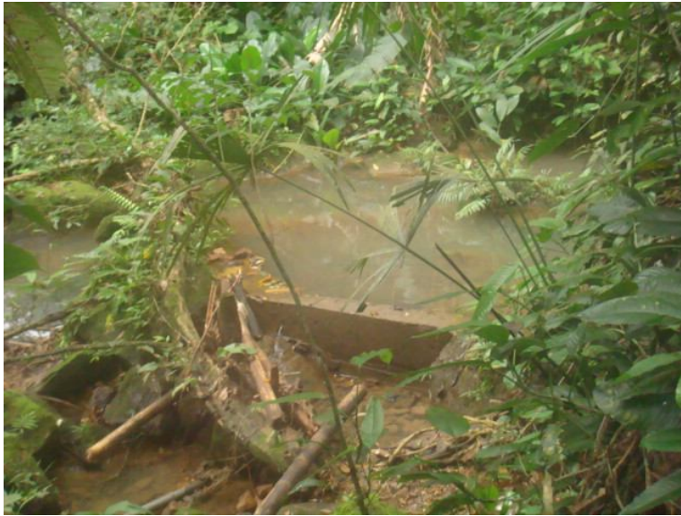
Foto 34. Antigua boca toma de La Tribuna
