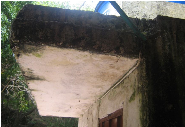
Foto 29. Circuito eléctrico con cables expuestos en los baños
