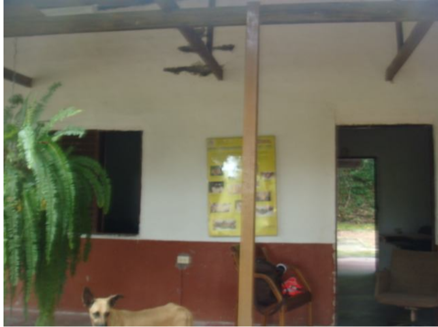
Foto 8. Frente casa principal
