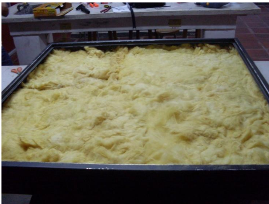
Foto 15. Adecuación de los materiales del colector solar, Grupo trabajo de grado
