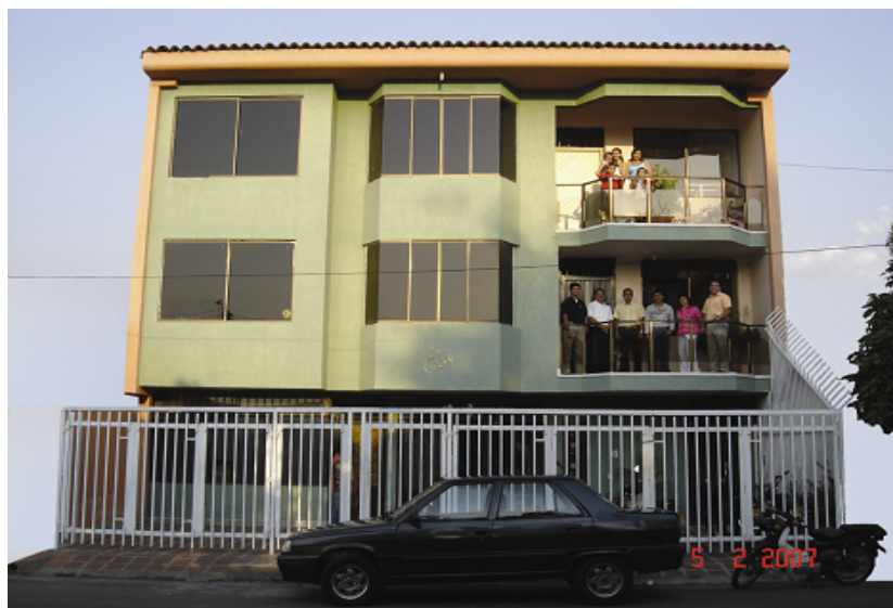
Oficina ubicada en la carrera 8 a nº 18 a 40 Barrio: Camponúñez
