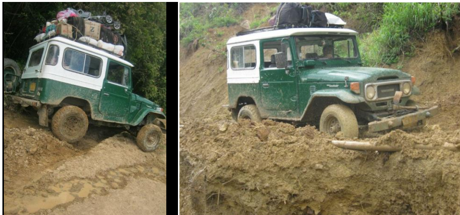
Imagen N°:39 Vehículo de propiedad del Sr. Jordanel Ortigoza, en la imagen se puede observar el mal estado de la vía.
