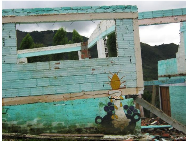
Imagen N°.22 Vivienda destruida por un deslizamiento en la vereda San Emilio. Mayo de 2011.
