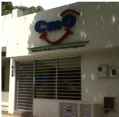
Imagen N°27 fachada CMO carrera 7 con calle 19
