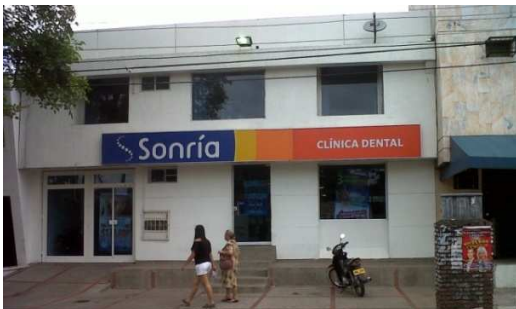
Imagen N°26 fachada Sonría Carrera 7 N°10- 26
