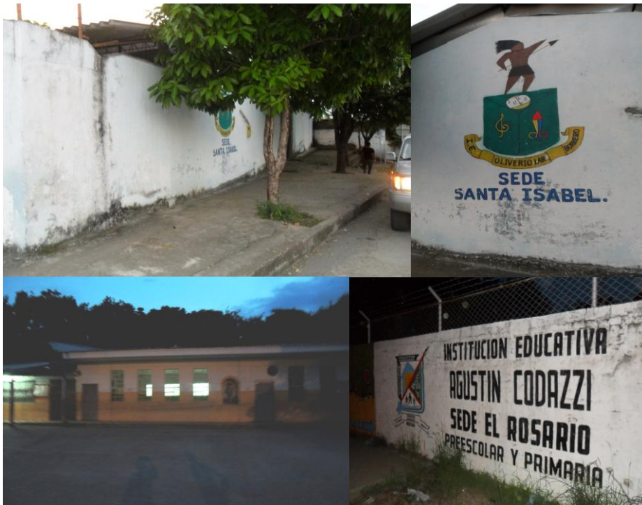
I.E. Oliverio Lara, sede Santa Isabel, construida en el año 1966, carrera 22 entre calle 12 y 13. I.E. Agustín Codazzi sede el Rosario, construida en el año 1973, carrera 15 y calle 2, esquina. 04 de enero de 2011. Fotógrafo Carlos Alirio.
