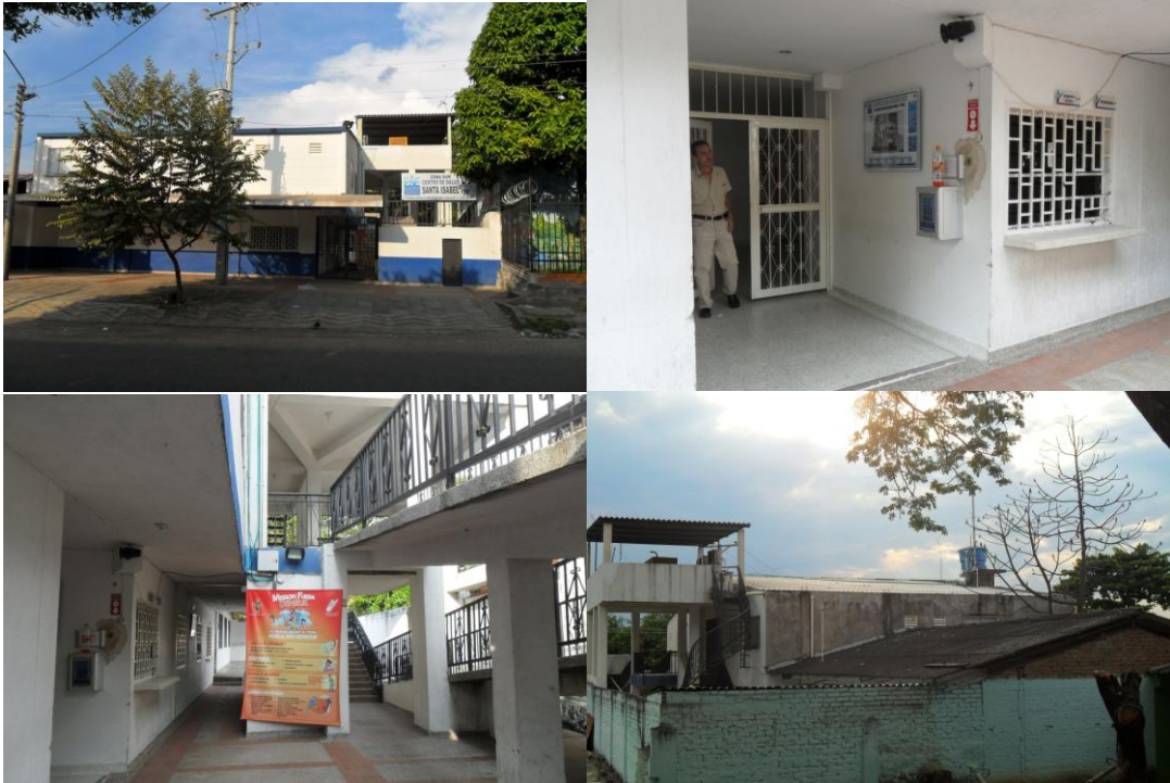
Centro de Salud de Santa Isabel. Carrera 21, entre calles 11 y 12. Estructura externa e interna. Construido en el año 1973 a 1975 con la marcha del ladrillo organizada por el Dr. Rodrigo Lara Bonilla y el presidente de la JAC Nelson Sánchez. 04 de enero de 2011. Fotógrafo Margarita.
