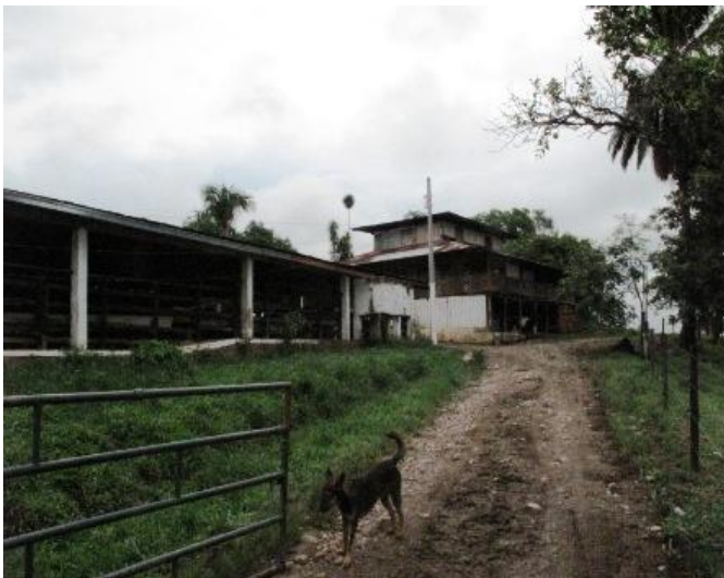
IMAGEN 03. Finca Reinaldo Gómez, Km. 3,5. Tomada y afectada.
