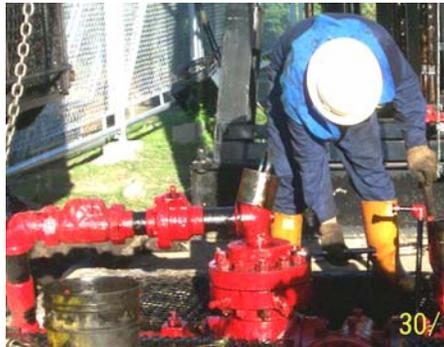
*Figura 25. Venteo de un pozo*
