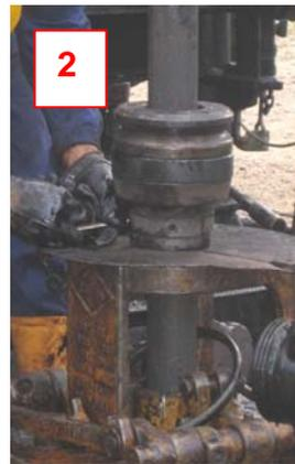
4.3.5 Con la mesa de cuñas cerrada y sosteniendo la sartas de tubería, soltar el casing head con el pup joint.
