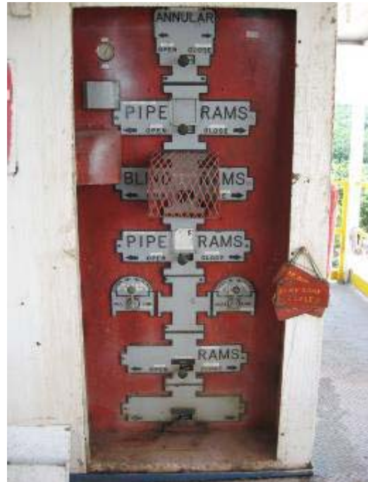
Figura 26. Control remoto de BOP
