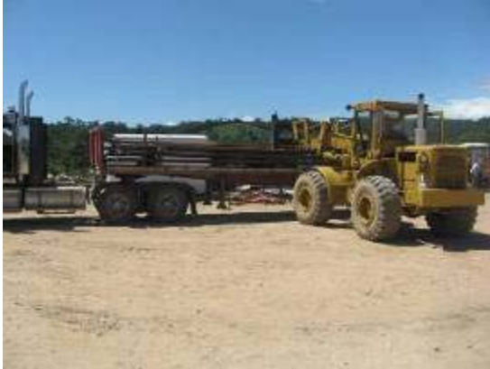
Figura 11. Cargue de tubería
