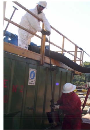
Figura 44. Obrero y supervisor fuera del tanque
