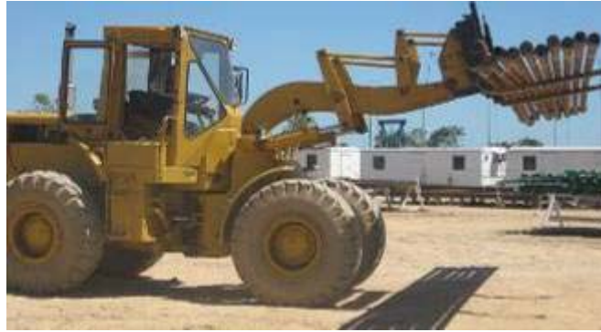
Figura 5. Cargador transportando tubería.
