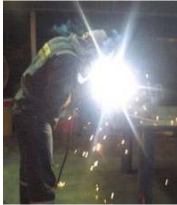
Figura 34. Operación de soldadura
