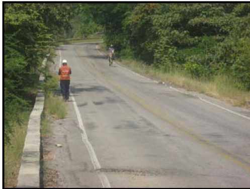
Figura 13. Fotografías Punto Crítico Fallas Geológicas, Superficie Rizada Y Huecos En La Vía.
