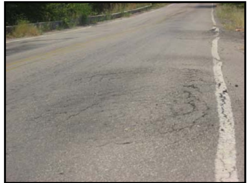
Figura 13. Fotografías Punto Crítico Fallas Geológicas, Superficie Rizada Y Huecos En La Vía.
