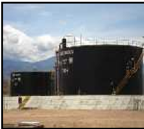
Figura 11. Muros de contención.
