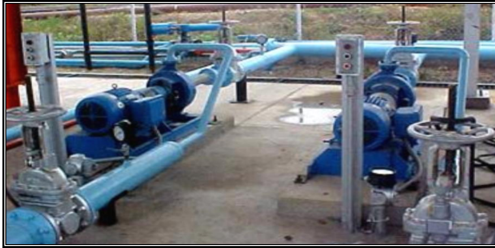
Foto 8. Bombas Booster de Inyección
