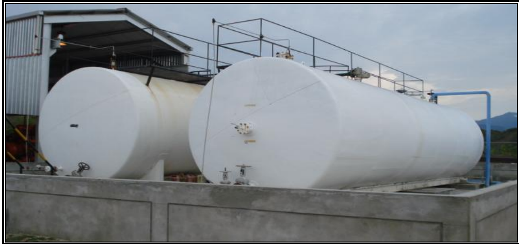
Foto 7. Tanques de cabeza isla de inyección
