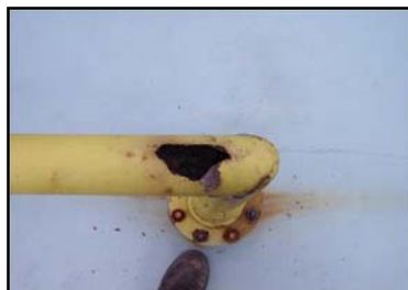
Fotografía 4. Corrosión en la línea de gas del tanque de almacenamiento TK- 05
