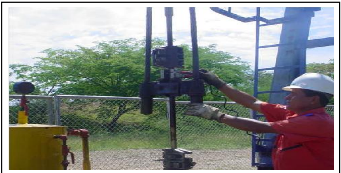
Figura 7. Instalación de la celda de carga
