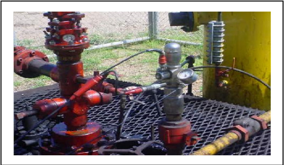
Figura 1. Instalación de la Pistola de Gas al anular del Pozo
