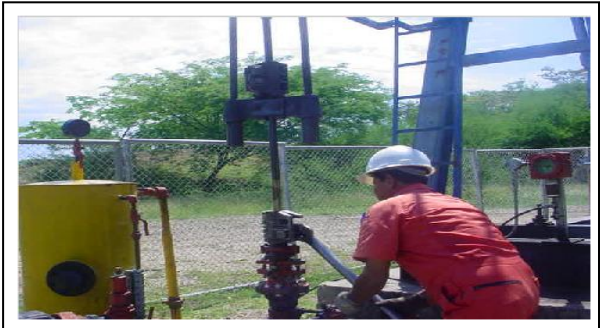
Figura 6. Instalación de la grapa a la barra lisa
