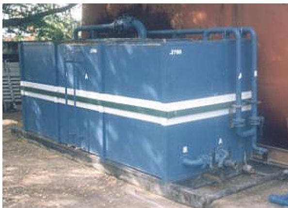
Figura 14. Gauge tank o tanque de medida
