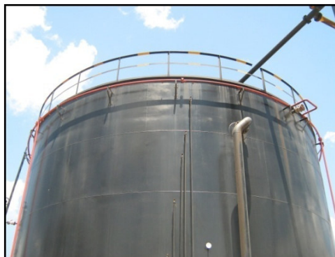
Foto 11.4. Anillo de Boquillas Pulverizadoras de Agua
