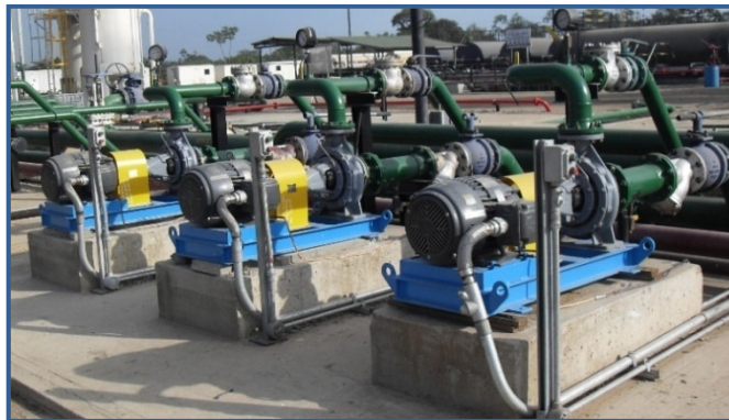
Foto 7.8. Bombas de Precarga Centrífugas
