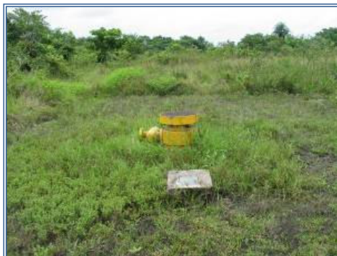
Foto 1.2. Válvula Tapón del Pozo Upía-1
