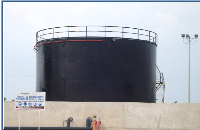
Foto 6.1. Tanque de Almacenamiento
