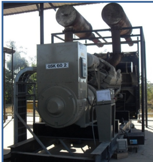
Foto 12.2. Generador Cummins
