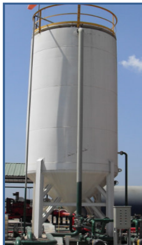
Foto 7.9. Tanque Decantador
