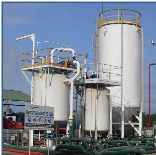
Foto 7.5. Planta Tratamiento de Agua
