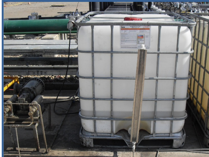
Foto 3.1. Inyección de Químicos
