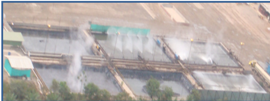
Foto 7.3. Piscinas de Tratamiento
