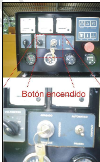
Figura 89. Interruptor de Encendido – Apagado, de los generadores.
