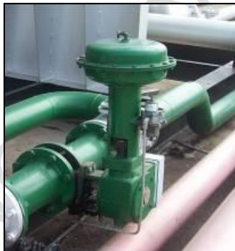
Figura 36. Válvula Automática Reguladora de Nivel de Agua
