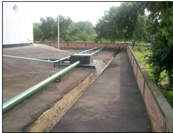
Figura 70. Cuneta del sistema de drenaje del patio del tanque 501.
