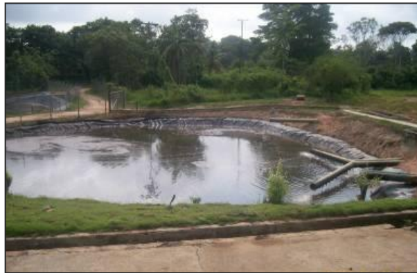
Figura 78. Piscina de Oxidación N° 1.
