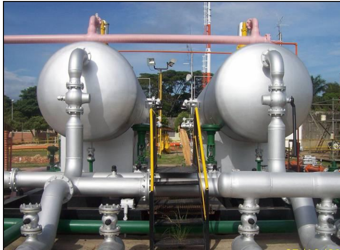
Figura 26. Separadores Generales GS-2 (Izquierda) y GS-1 (Derecha).
