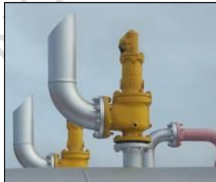
Figura 34. Válvula de seguridad de resorte
