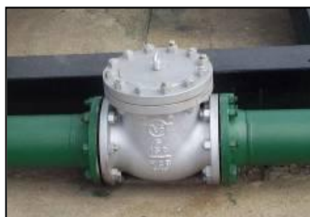
Figura 37. Válvula de Retención o Check
