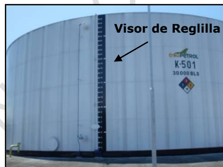
Figura 8. Visor de Nivel de Reglilla en tanque de almacenamiento.
