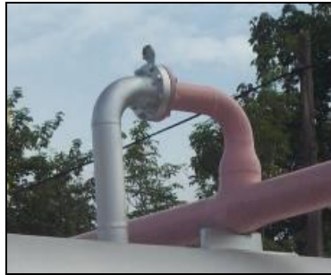
Figura 35. Platillo de seguridad o Disco de Ruptura
