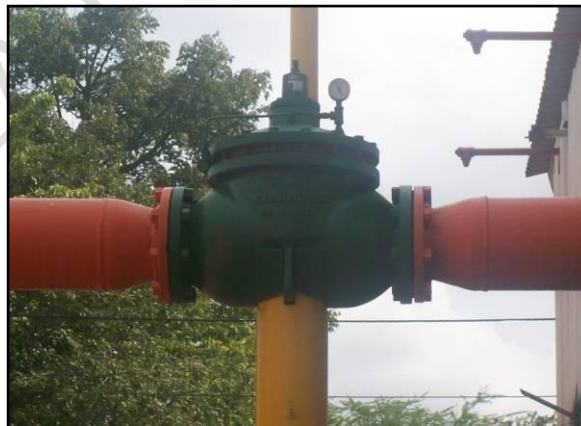
Figura 16. Válvula reguladora de presión Kimray en línea de succión a compresor.
