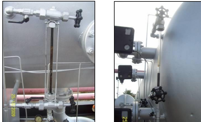
Figura 7. Visores de Nivel de Vidrio
