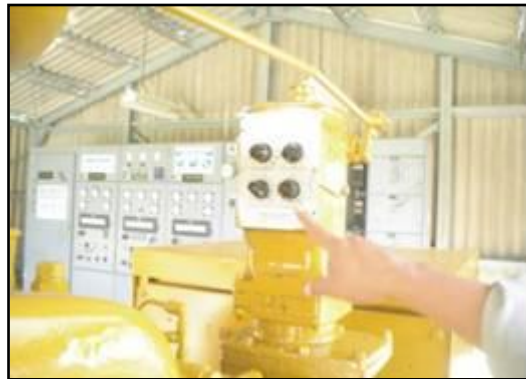
Figura 88. Sincronizador del Gobernador.
