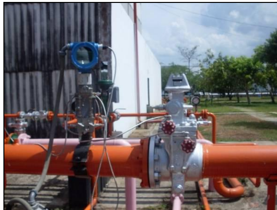
Figura 6. Medidor de orificio Daniel's
