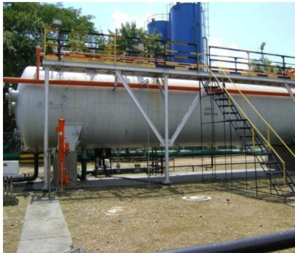
Figura 5. Separador Trifásico Horizontal
