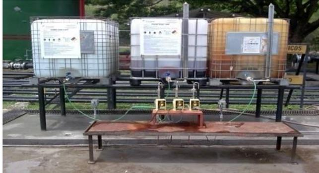
Figura 4. Sistema de Inyección de Químicos
