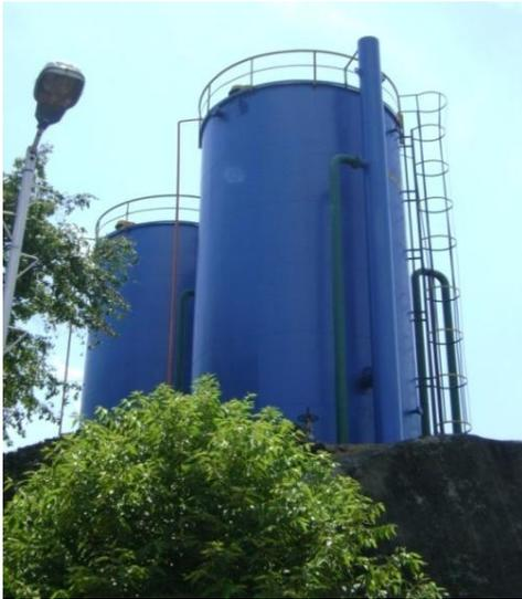
Figura 9. Skimming Tank (Desnatador)
