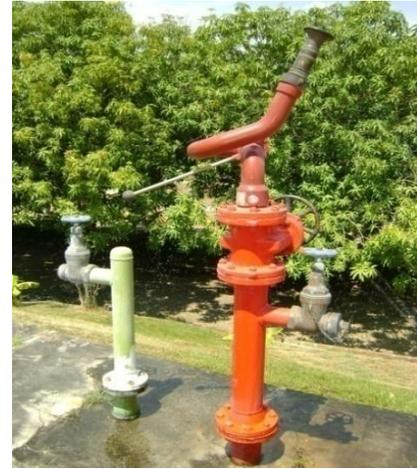
Figura 21. Hidratante Monitor
