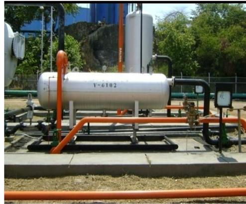
Figura 7b. Separador Bifásico Horizontal
