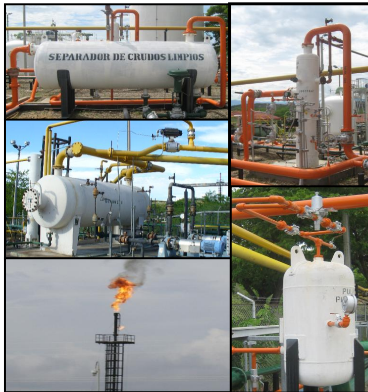
Figura 8. SEPARADOR CRUDOS LIMPIOS, SCRUBBER GENERAL, KNOCK OUT DRUM, TEA Y TANQUE PULMÓN PILOTO TEA.
