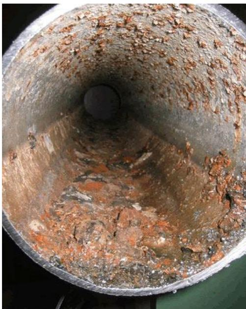
*Ilustración 4. Corrosión en parte interna de la tubería*
