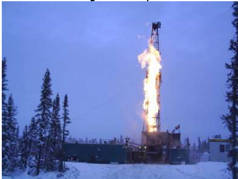
FIGURA 1. Fotografía de un pozo incendiado
