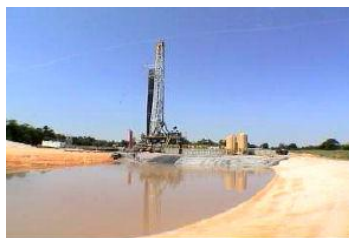
Figura 105. Tanque de reserva
