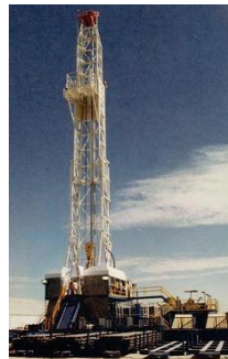
Figura 33. Equipo Fastrac en Pozo
