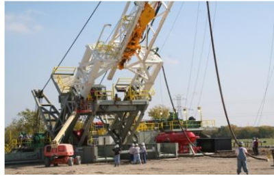
Figura 153. Izaje del Rocket Rig
