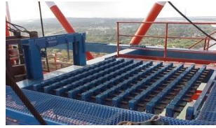
Figura 17. Sistema de Acomodo de Tubería en el encuelladero
