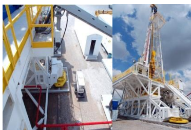
Figura 9. Foto lateral del Gato hidráulico de Desplazamiento Direccional y equipo listo para deslizamiento
