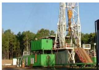
Figura 98. Tanque de agua
