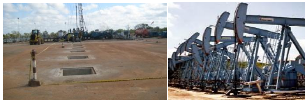
Figura 1. Perforación Tipo Cluster en el pozo LOC YC 009-1 en Venezuela
