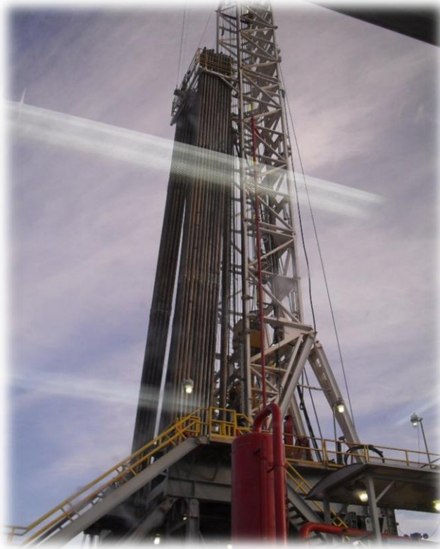
Figura 1.2. Equipo de perforación en tierra (Foto Pioneer 51, Campo Castilla Norte, 2011)
