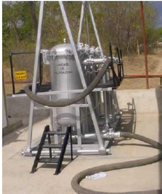
Figura 4. Unidades de filtración 5
