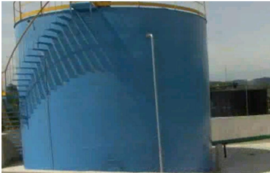
Figura 12. Tanque Desnatador Estación Toldado.
