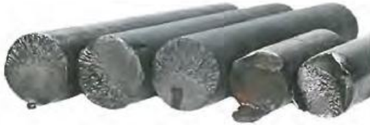
Figura 32. Ejemplo de fallas por defecto de fabricación.
