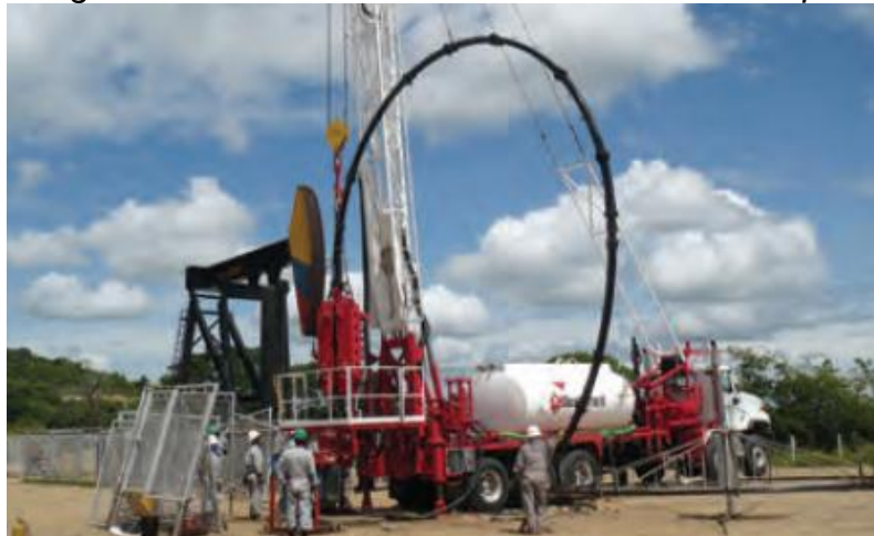
Figura 34. Instalación de varilla continua en campo.
