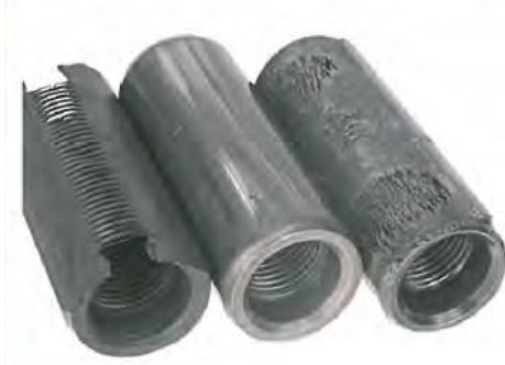
Figura 11. Ejemplos de fallas inducidas por defectos en el diseño y operación.
