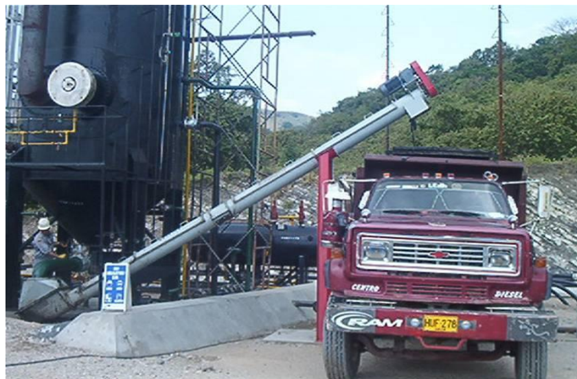
Figura 27. Extracción de arenas del tanque desarenador.
