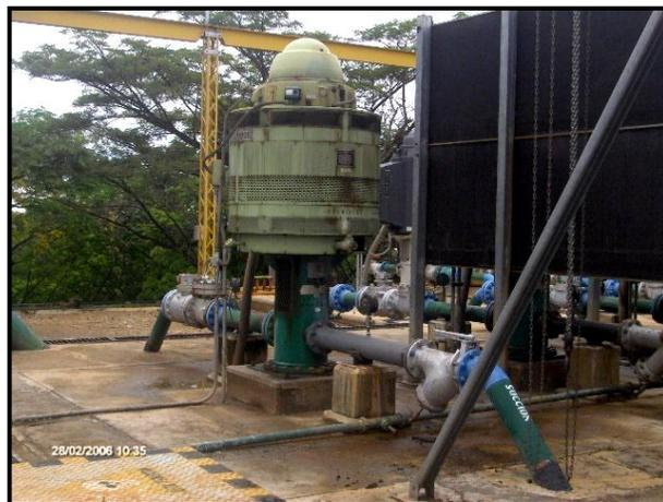
Figura 25: Bombas de inyección.
