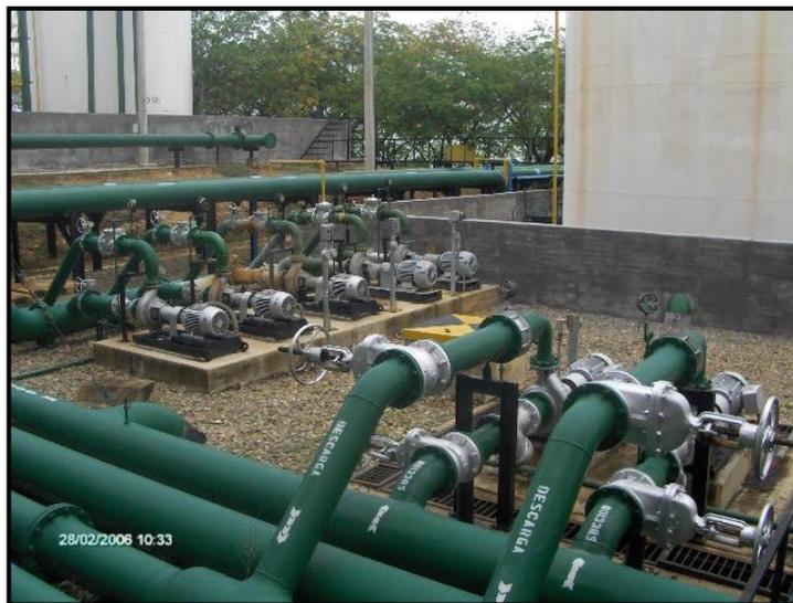
Figura 15: Bombas de filtración.
