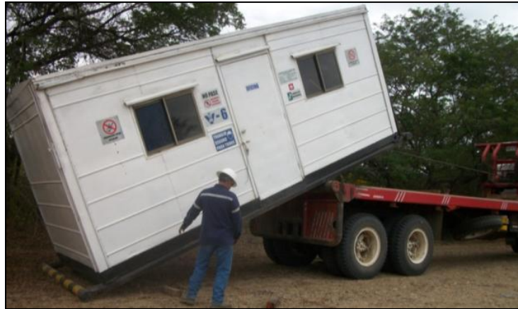
Figura N° 49. Bajar la carga hasta caer al suelo el patín (skid).
