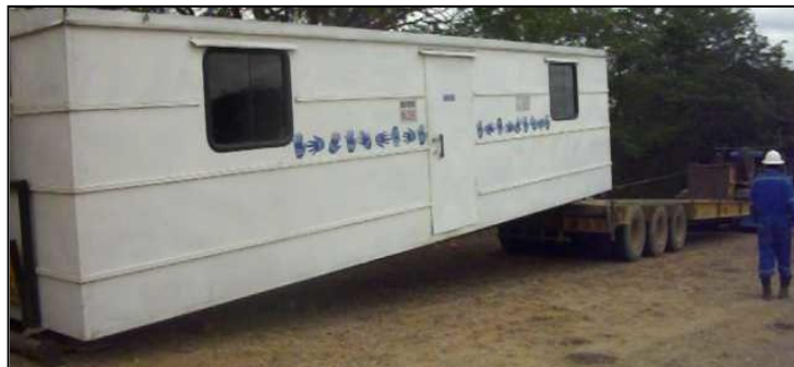
Figura N° 57. Bajar la carga hasta caer al suelo el patín (skid).
