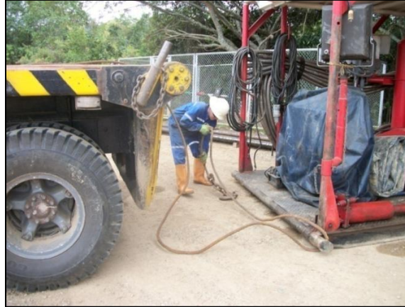
Figura N° 31. Sujetar o amarrar la carga a levantar.
