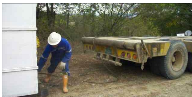
Figura N° 58. Retirar el cable del vehículo tracto camión atado a la carga.
