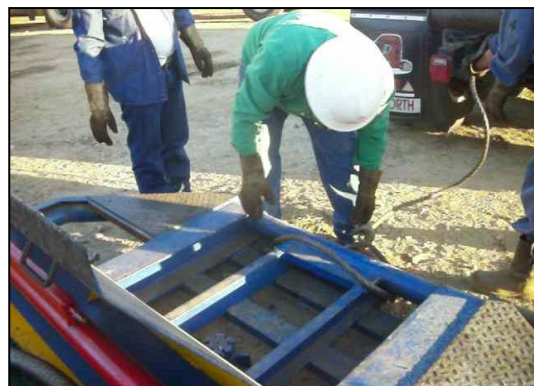
Figura N° 67. Posición correcta al sujetar o amarrar el safety move a levantar.
