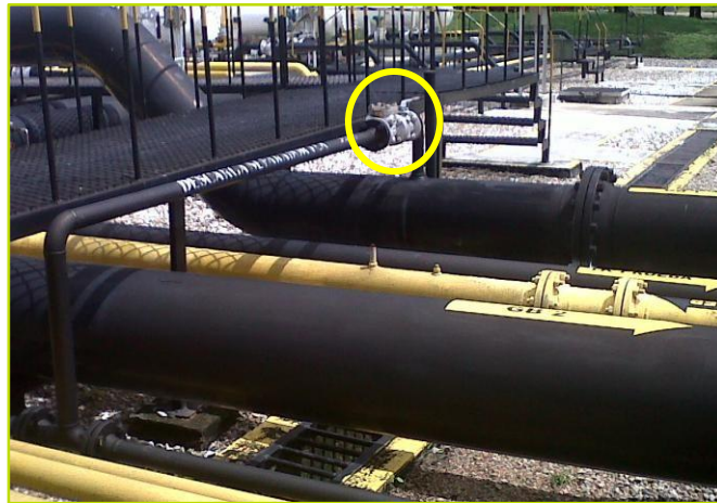
Figura 6. Válvula de descarga del KOD al Gun Barrel S-ABK-101.
