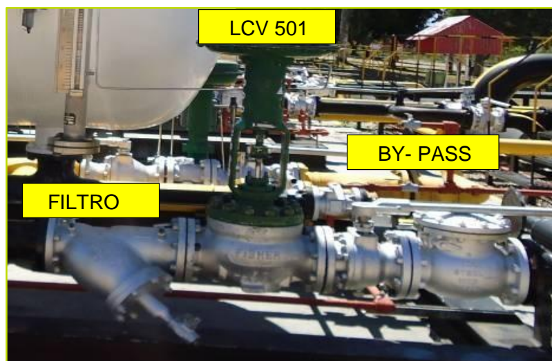
Figura 3. Válvula LCV-501 del Separador S-MBD-107.
