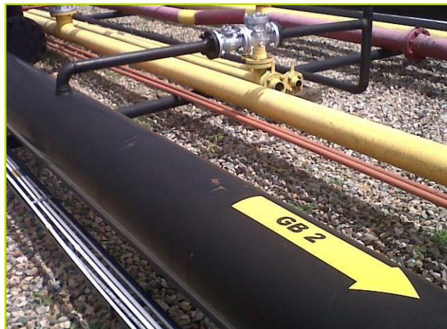
Figura 6. Válvula de descarga del KOD al Gun Barrel S-ABK-102.
