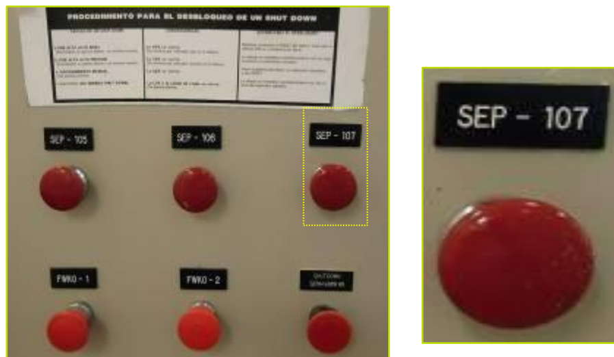
Figura 2. Botón de la válvula SDV-501.
