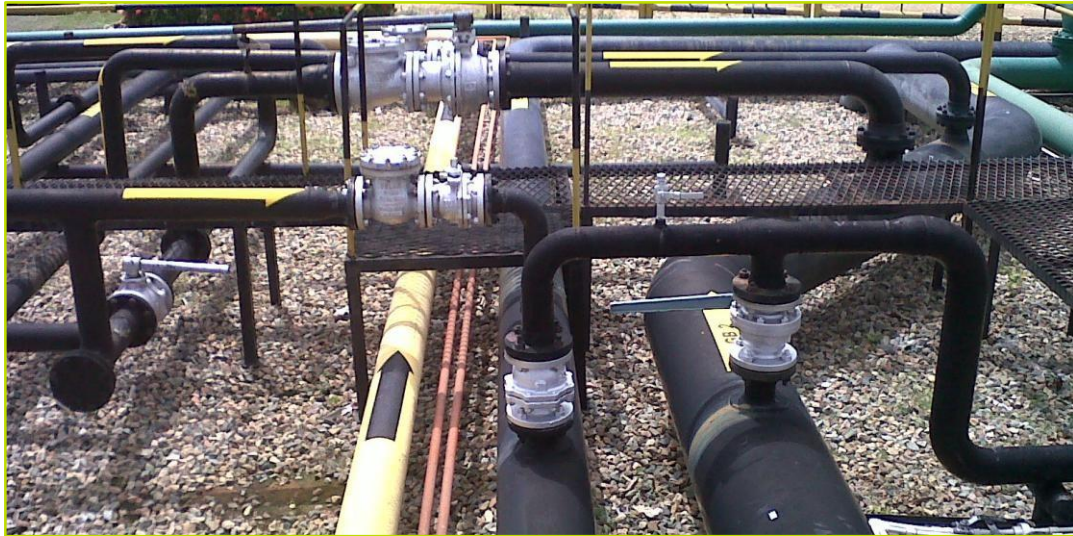
Figura 2. Salida de crudo de los FWKO S-MAM-101 y 102.
