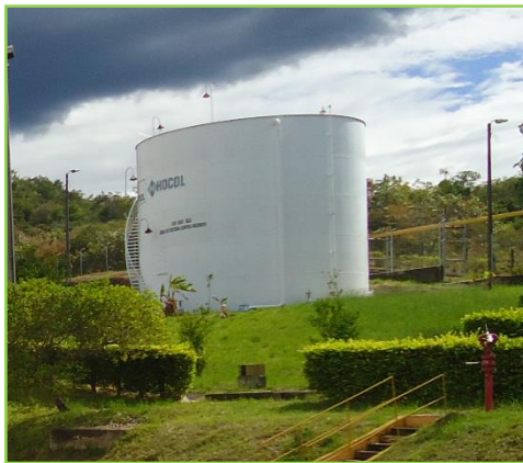
Figura No.53 Tanque de suministro de Agua
