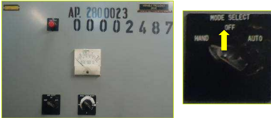
Figura 17. Variador de velocidad Robicon. MODO SELECT.
