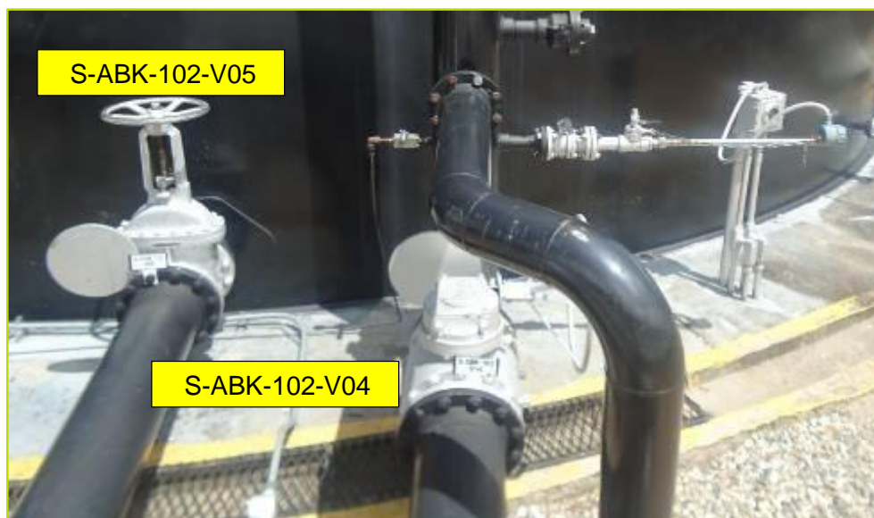
Figura 9. Salida de crudo del Gun Barrel S-ABK-102.
