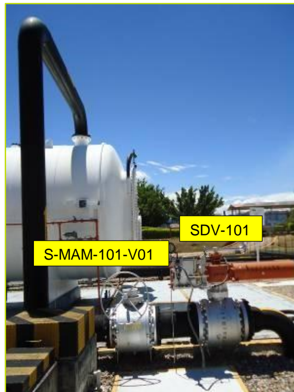
Figura 1. Válvula de entrada S-MAM-101-V01 y SDV-101 del FWKO S-MAM-101.
