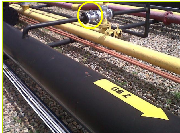
Figura 5. Válvula de descarga del KOD al Gun Barrel S-ABK-102.
