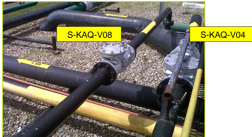
Figura 3. Válvula de salida del FWKO S-MAM-101 y recirculación del Skimmer.
