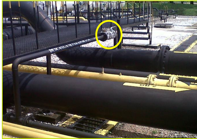
Figura 5. Válvula de descarga del KOD al Gun Barrel S-ABK-101.
