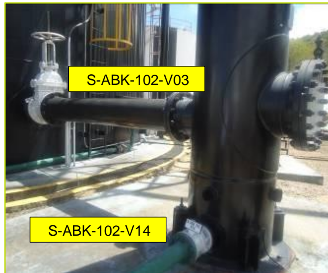
Figura 8. Entrada al Gun Barrel S-ABK-102.
