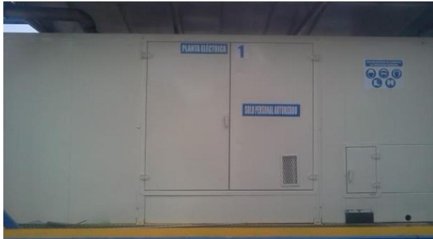
**ILUSTRACION 71:** Planta eléctrica distribuida por Stewart and Stevenson, compuesta por un motor diésel Deutz y un generador Stamford. Fuente: Varisur y Compañía Ltda. 2014
