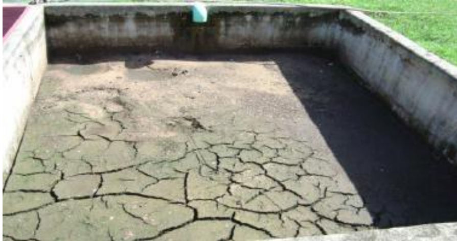
Figura 3.5 Secado de los lodos de perforación
