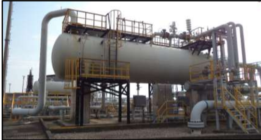
Figura 14. Slug Catcher de Recetor
