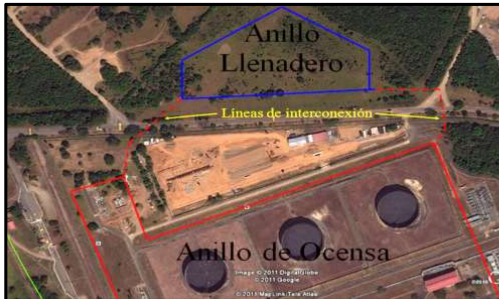
Figura 20. Vista aérea llenadero de GLP.
