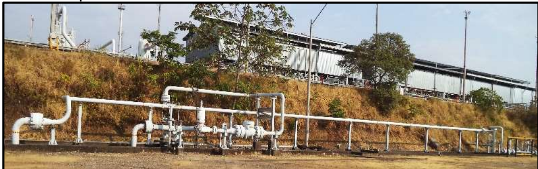
Figura 13. Jumper de Recetor
