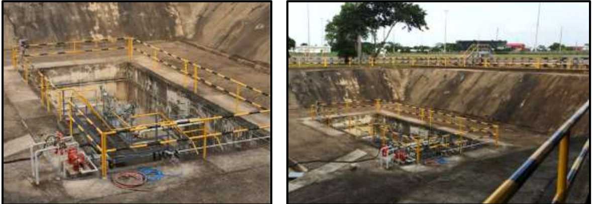
Figura 24. K.O. drum de Llenadero de GLP
