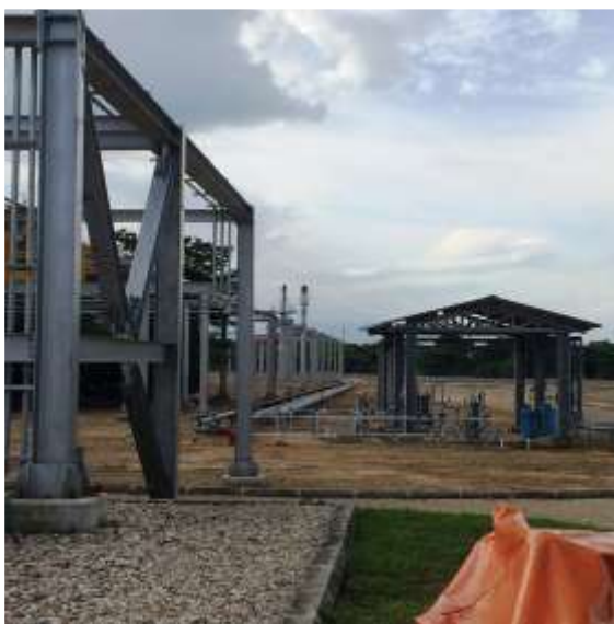
Líneas de GLP hacia tea
