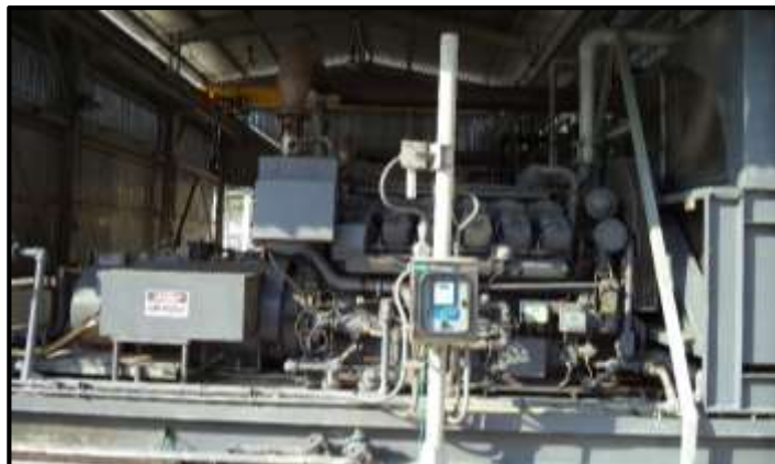
Figura 11. Sistema eléctrico de Recetor
