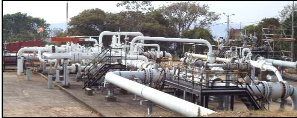
Figura 12. Manifold de Recetor
