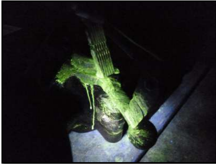
15. Pieza inspeccionada con partículas magnéticas
