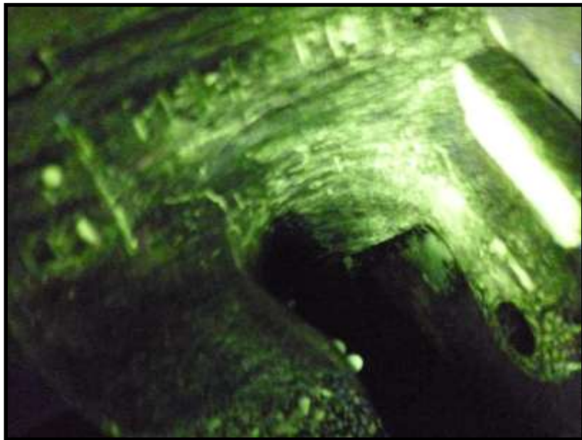
12. Discontinuidades en la pieza inspeccionada con partículas magnéticas
