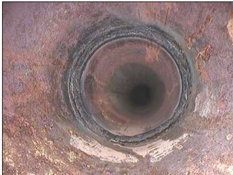
Figura 19: Interior de una tubería de perforación vista con un baroscopio Fuente: IPI.FX Co
