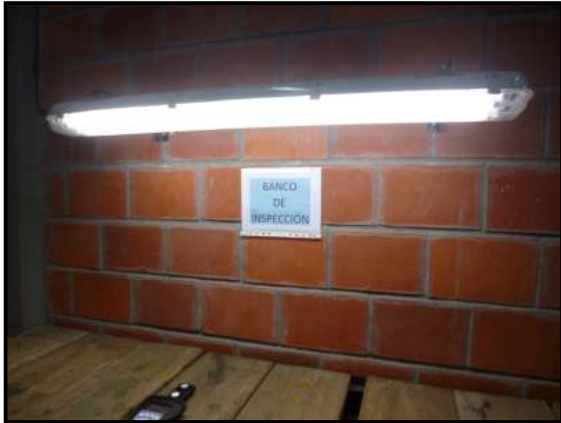
23. Banco de inspección
