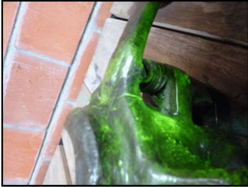
7. Pieza inspeccionada con partículas magnéticas
