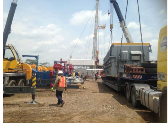
Figura 37. Cargando Tanque de lodos
