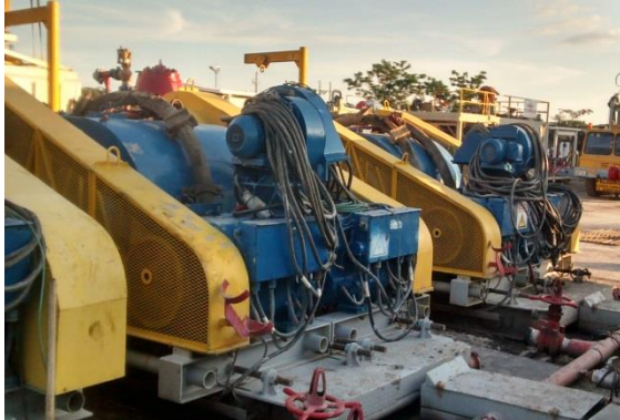
Figura 34. Desconexión y ubicación de cableado eléctrico de las bombas
