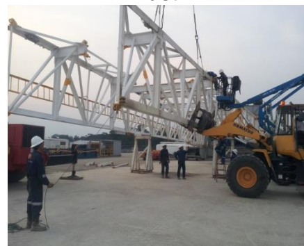
Figura 80. Anclaje de secciones del mástil
