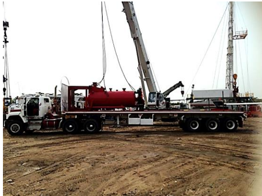
Figura 42. Cargando desgasificador de lodos
