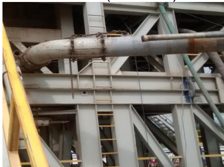
Figura 15. Desarme de línea de retorno (Flow line)
