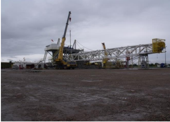
Figura 81. Instalación de líneas del mástil
