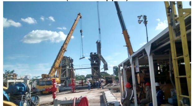
Figura 63. Bandeja de cableado (Grasshopper)
