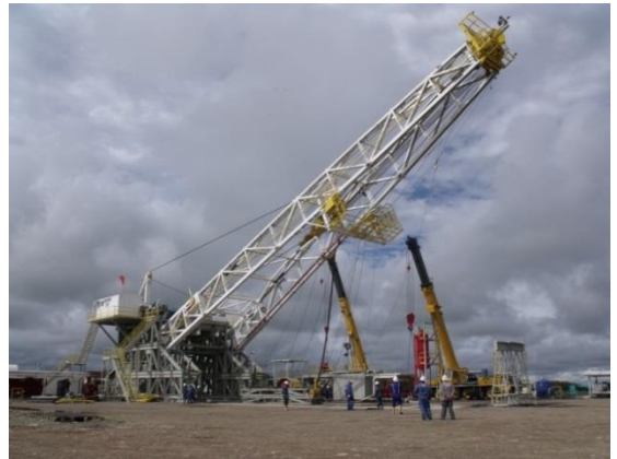
Figura 83. Mástil en posición final y pernado en la parte inferior con la subestructura
