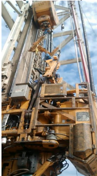
Figura 26. Sistema de levantamiento asegurado al bloque
