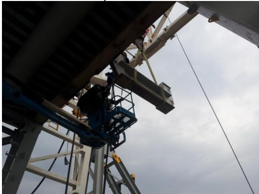
Figura 60. Bajando soportes del piso de perforación
