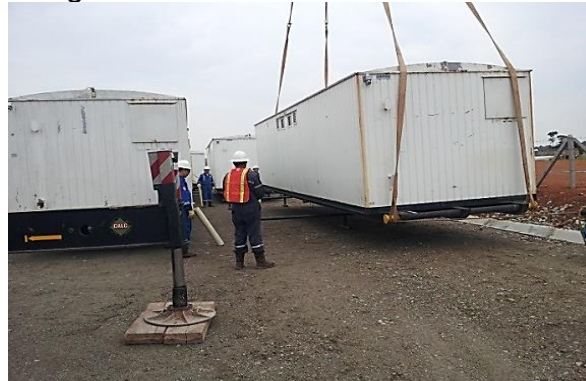
Figura 68. Levantamiento de casetas
