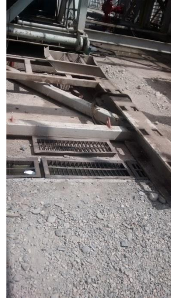
Figura 74. Puentes inferiores de la subestructura
