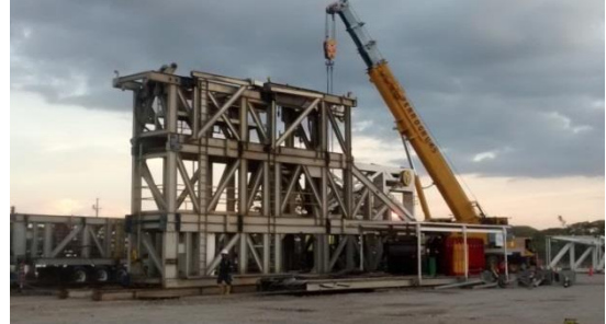
Figura 76. Terminando de armar la sección derecha de la subestructura
