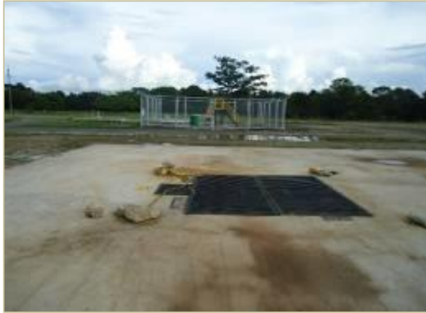
Figura 7. Contrapozo con rejilla y plataforma de concreto
