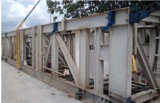
Figura 75. Base de la subestructura
