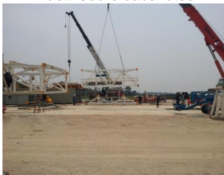
Figura 79. Posicionando secciones del mástil sobre caballetes
