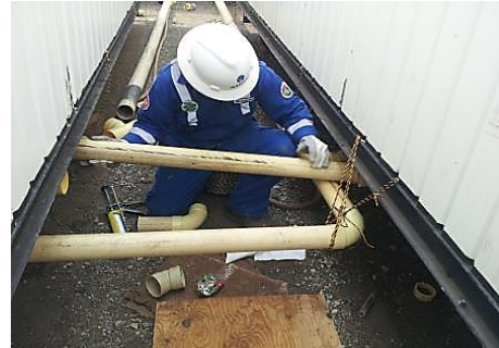
Figura 67. Desconexión de la red sanitaria
