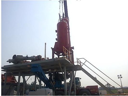
Figura 40. Desarme del desgasificador (poor boy)
