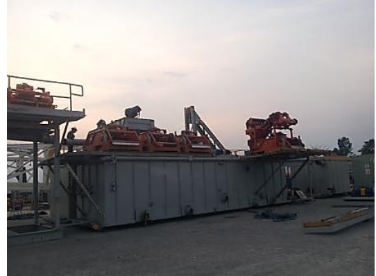
Figura 70. Posicionando zarandas de lodos
