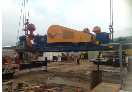
Figura 35. Levantamiento de bombas de lodos en su respectivo patín (skid)
