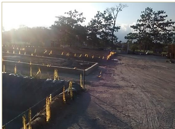
Figura 8. Piscina para tratamiento de recortes de perforación
