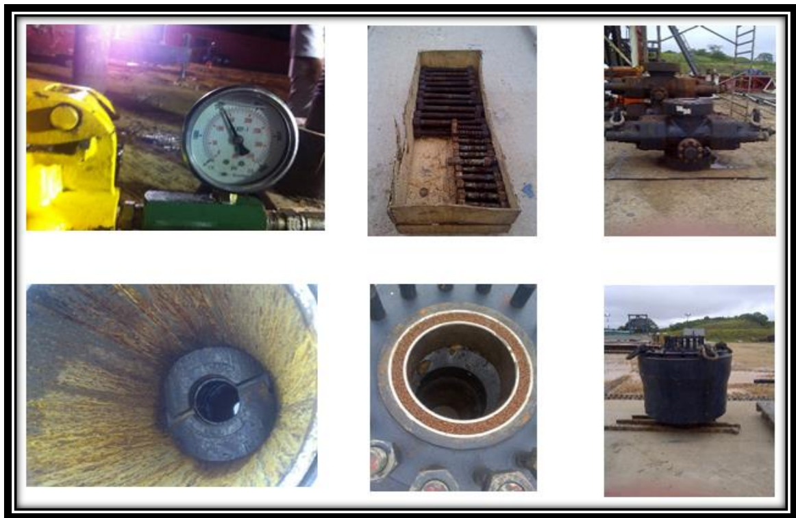
Ilustración 32 Fotos de inspección de BOP
