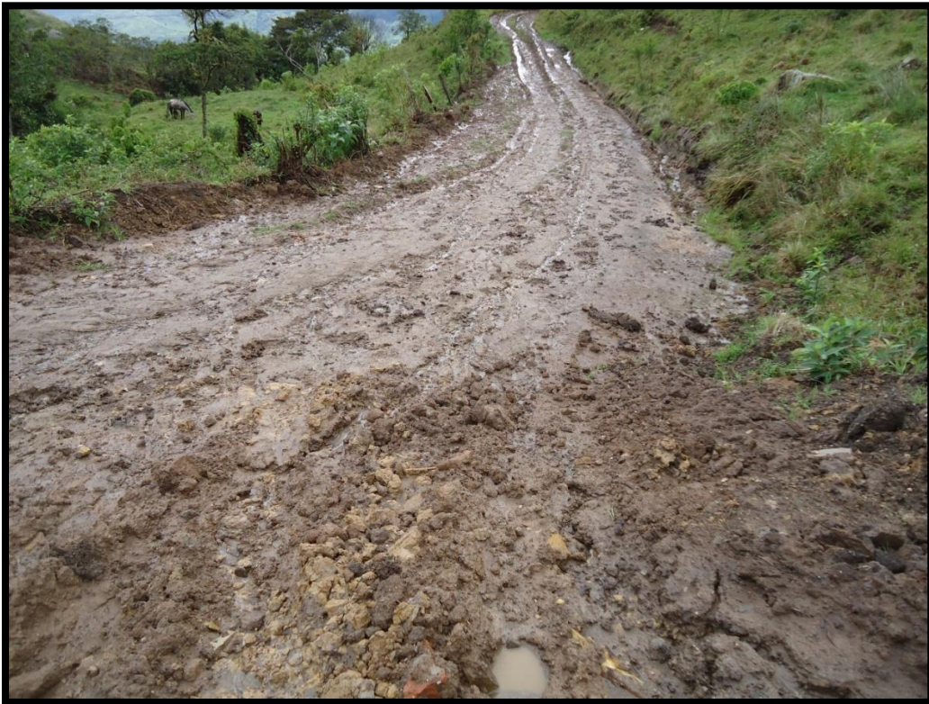
Fotografía 4 Vía de acceso a los puntos PT 39 y PT 40.
