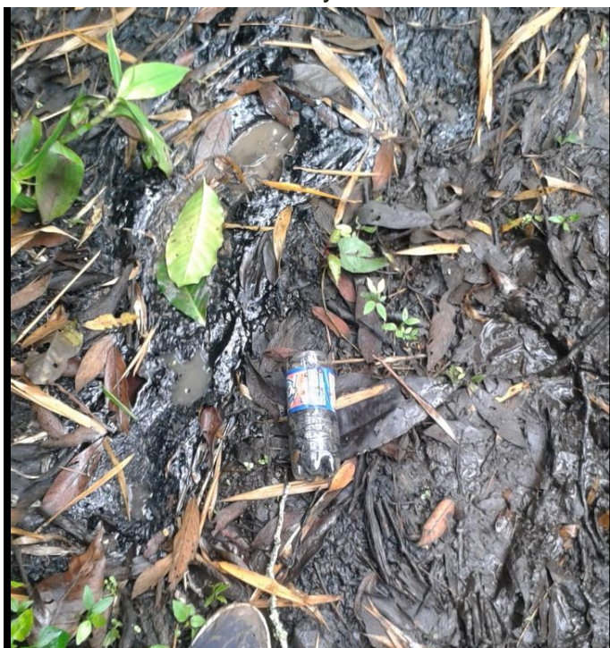
Fotografía 22. Asfalto en la vereda las Juntas
