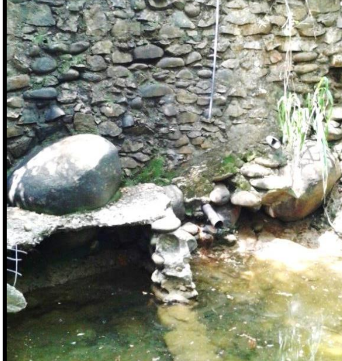
Fotografía 33. Estanque de agua; construido como fuente de abastecimiento para consumo interno de la Finca zona donde se presenta la iridiscencia.
