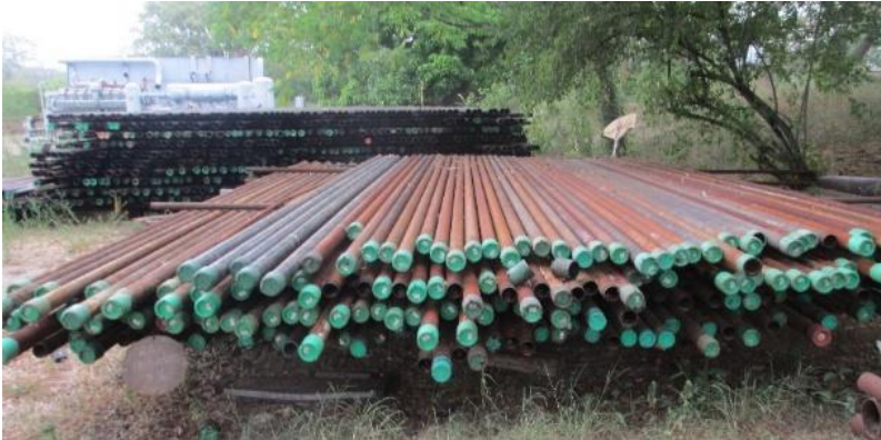
Ilustración 29. Mala distribución de tubos
