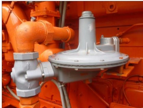
Fotografía 75. Válvula reguladora de presión del suministro del motor
