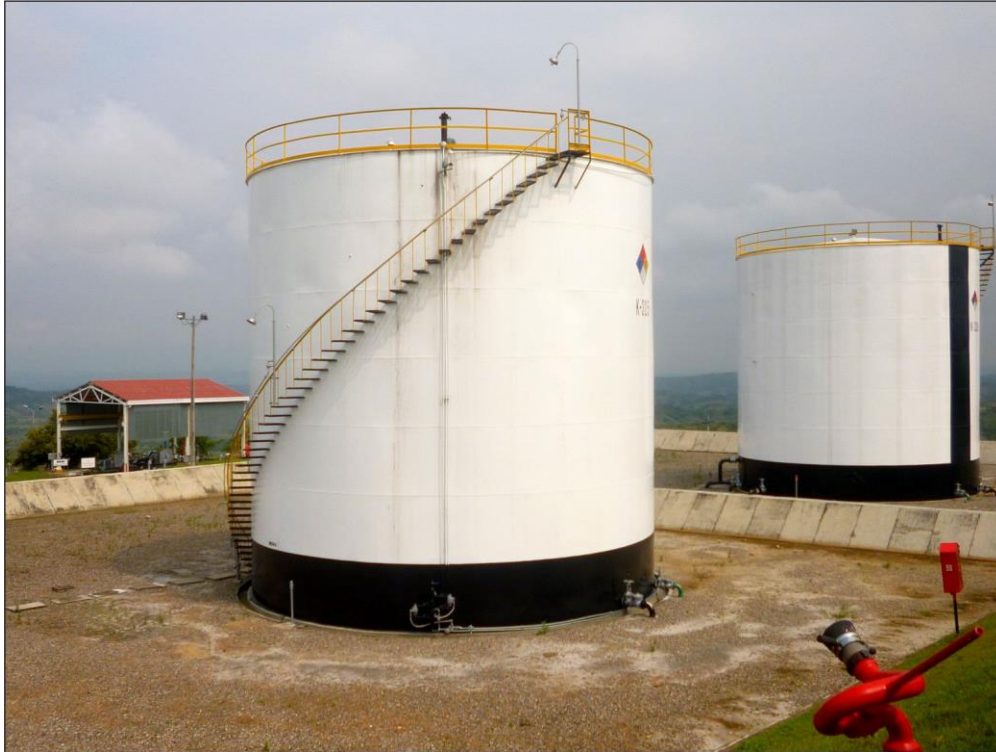
Fotografía 27. Tanques de almacenamiento
