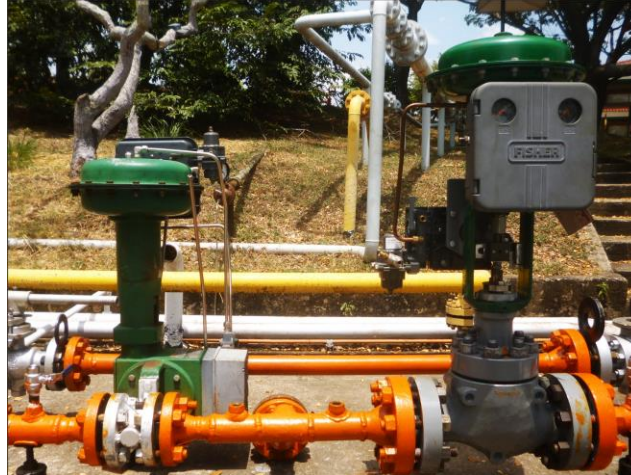
Fotografía 70. Válvulas de estrangulamiento previas al scrubber de consumo
