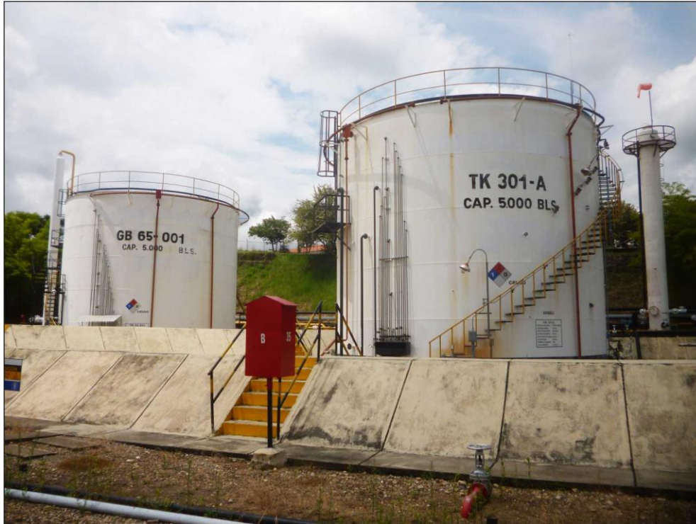
Fotografía 24. Área de gun barrels y botas de gas
