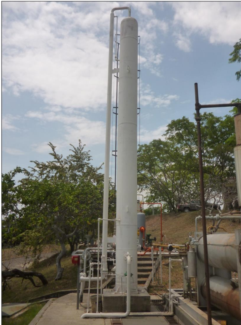
Fotografía 57. Torre contactora
