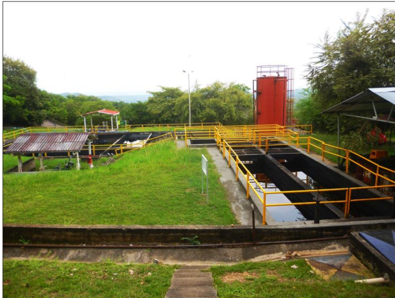
Fotografía 35. Piscinas API y de oxidación
