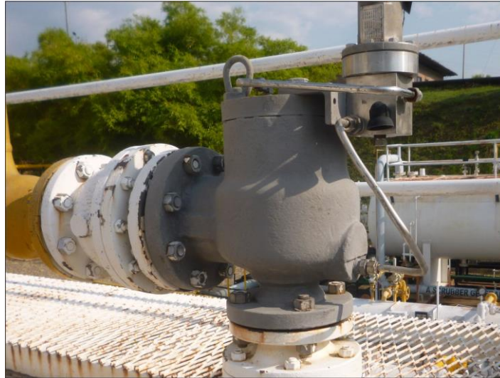
Fotografía 14. Válvulas de seguridad (PSV) de los separadores generales
