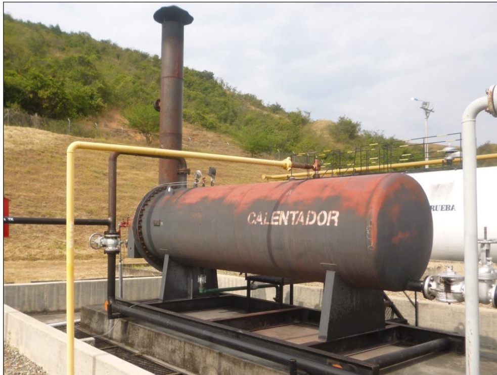
Fotografía 20. Sistema de tratamiento térmico
