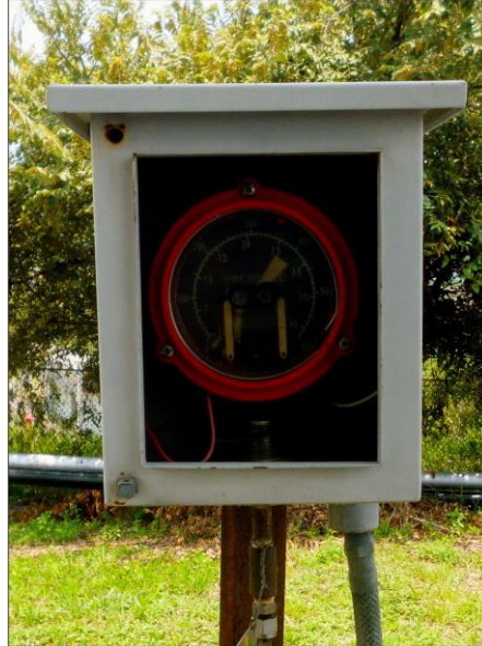
Fotografía 31. Switch de presiones límite (murphy)
