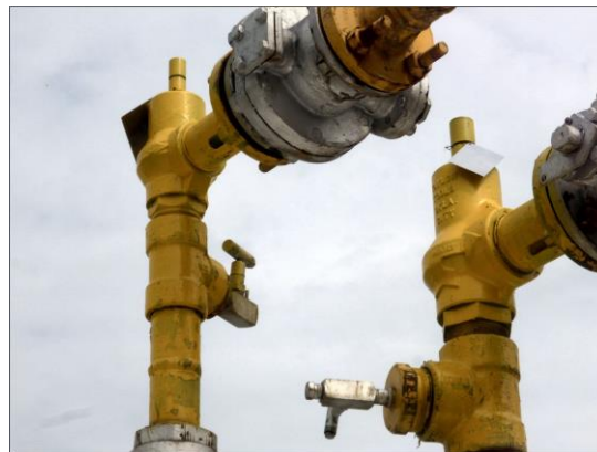
Fotografía 14. Válvulas de seguridad (PSV)
