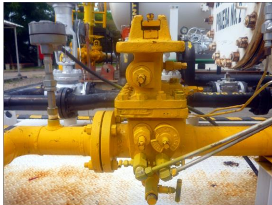
Fotografía 17. Medidor de platina de orificio
