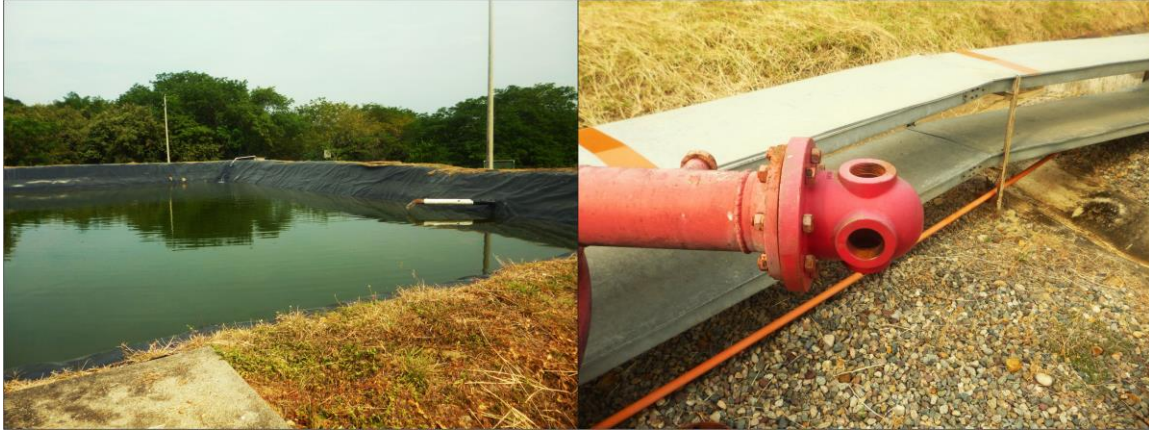
Fotografía 45. Piscina contra incendios / cabezal de prueba
