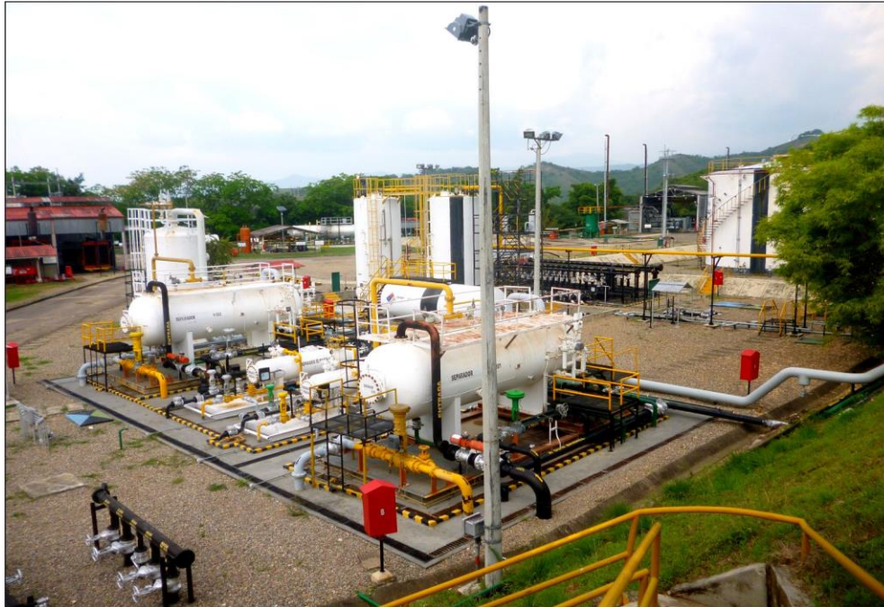
Fotografía 1. Vista general de la estación VENADO 1
