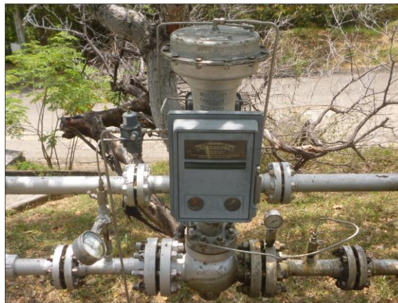
Fotografía 59. Válvula de estrangulamiento
