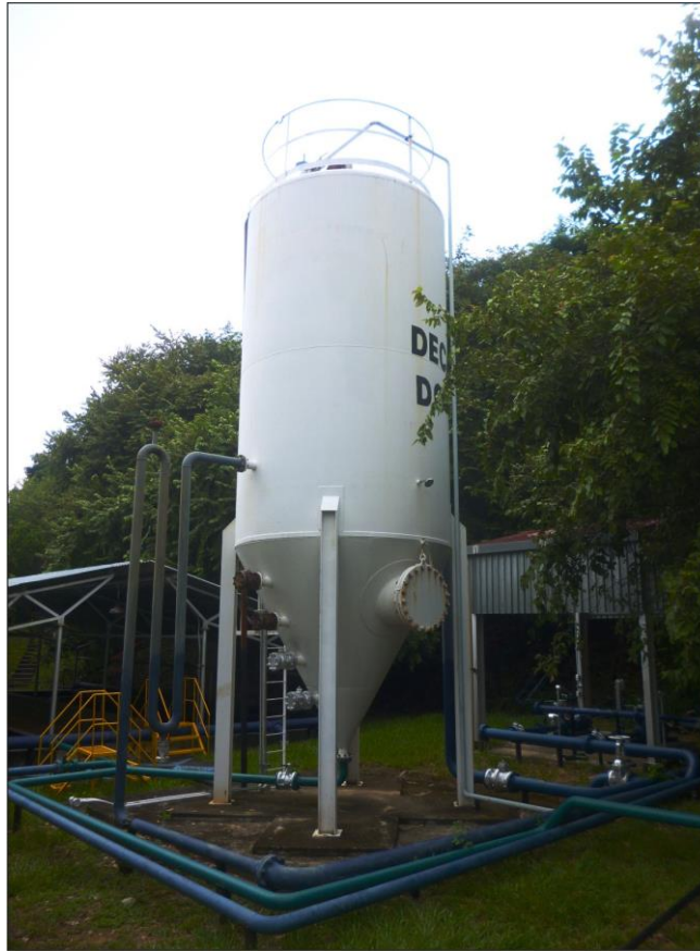
Fotografía 37. Decantador (DC-65-005)
