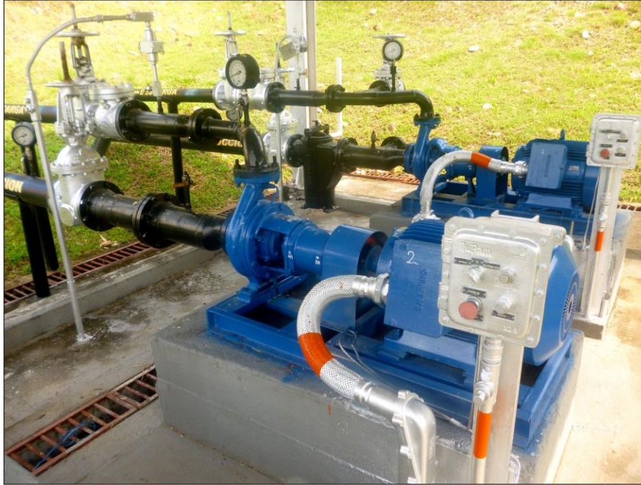
Fotografía 28. Bombas booster (D-319-A y D-319-B) para llenado de los tanques
