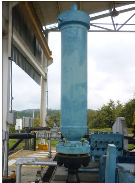
Fotografía 32. Amortiguador de flujo (dampener)
