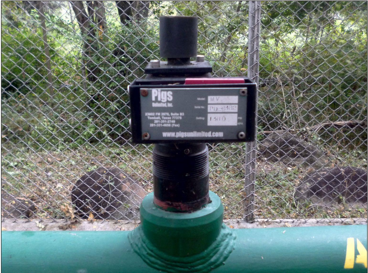
Fotografía 6. Indicador de paso para raspadores
