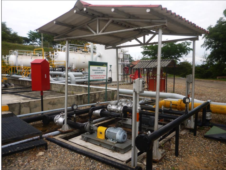
Figura 55. Válvulas y Líneas en el área de las bombas booster
