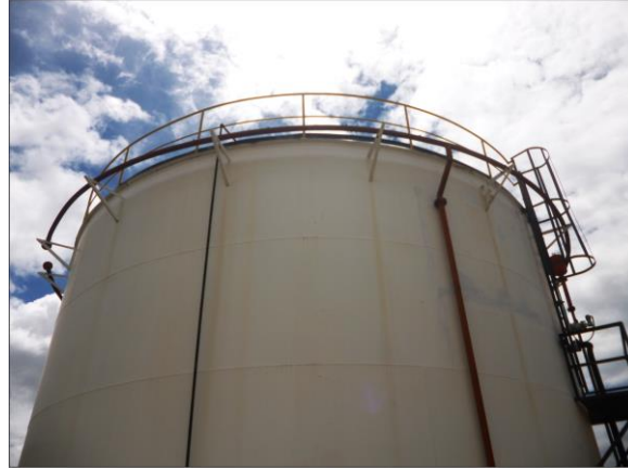
Fotografía 101. Anillo refrigerante del gun barrel TK-301-A
