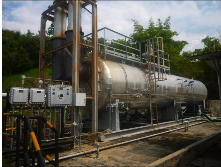
Fotografía 19. Calentador principal (H-65-001)
