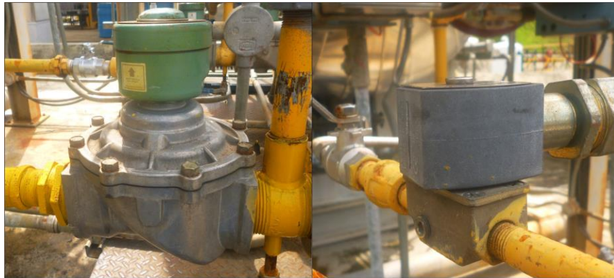
Fotografía 21. Válvulas de solenoide en las líneas de gas combustible para quemadores y pilotos
