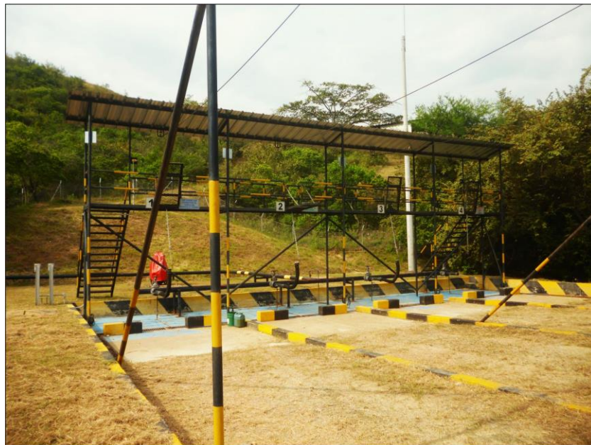
Fotografía 26. Área de cargue de vehículos cisterna
