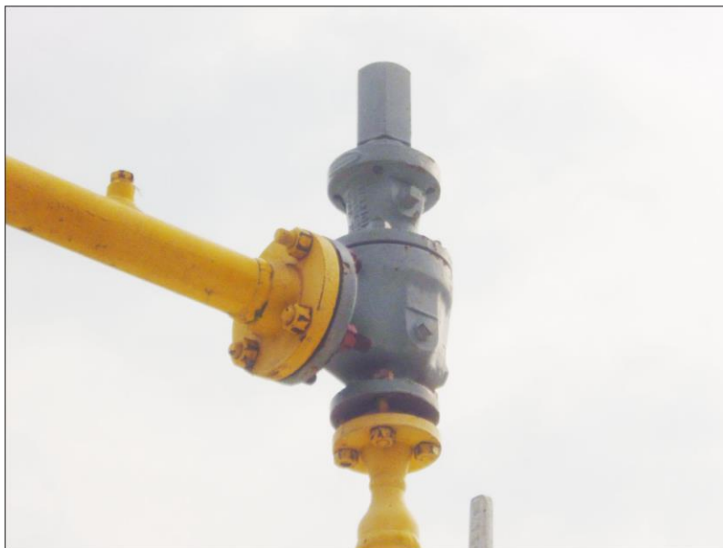
Fotografía 11. Válvula de seguridad (PSV)
