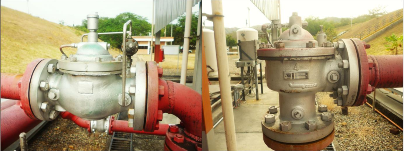
Fotografía 47. Válvula de alivio de la bomba 1 / válvula de alivio de la bomba 2
