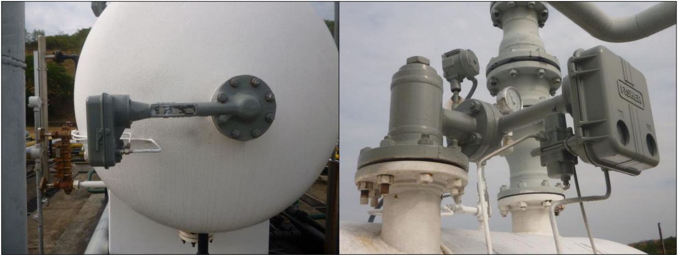
Fotografía 16. Switch de alto nivel (LSH) / Controlador de nivel (LC)
