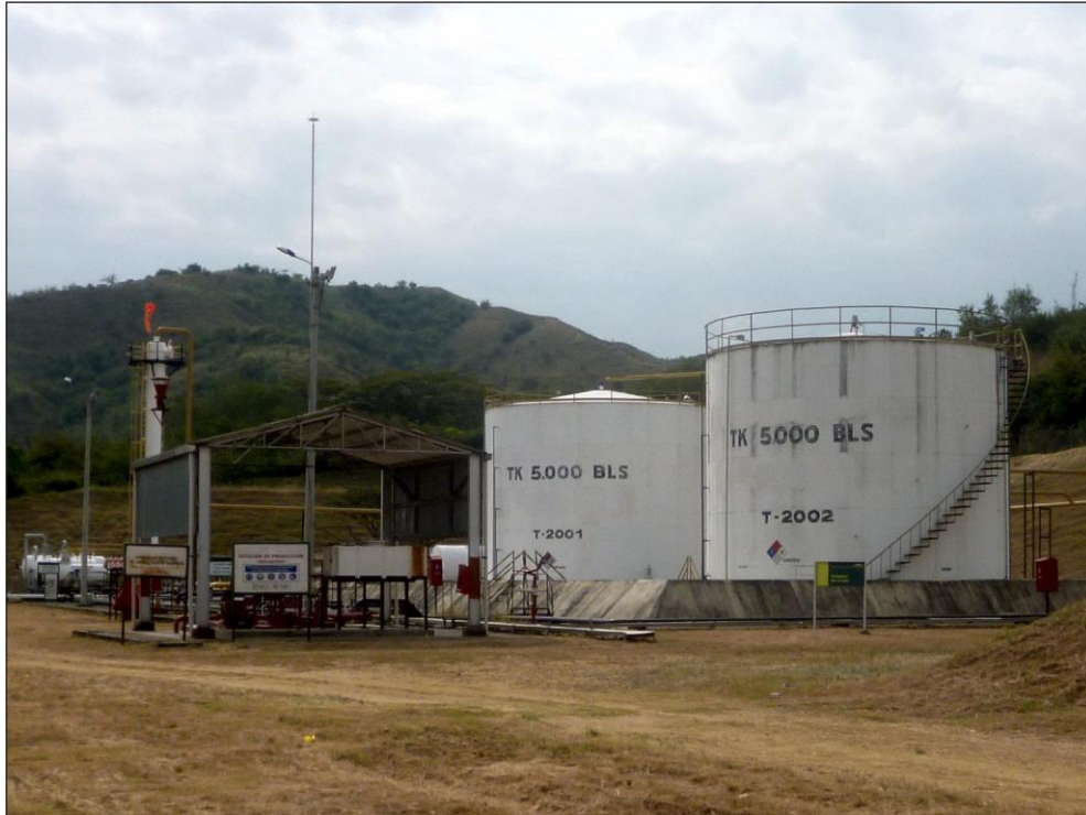
Fotografía 1. Vista general de la estación VENADO 2
