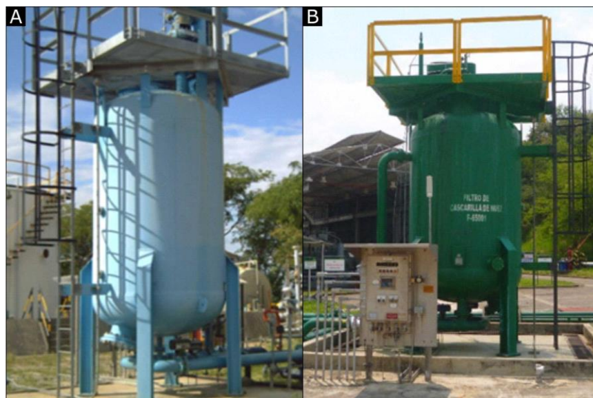
Ilustración 3. Registro fotográfico preexistente (A) y actual (B) del filtro de cáscara de nuez en Venado 1. Archivo S.A. LTDA
