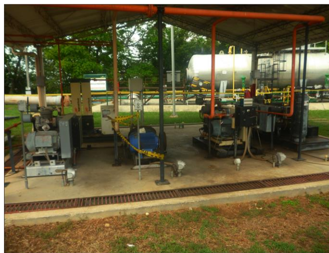
Fotografía 44. Motocompresores de aire
