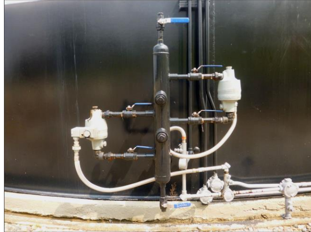
Fotografía 29. Arreglo de switch de nivel
