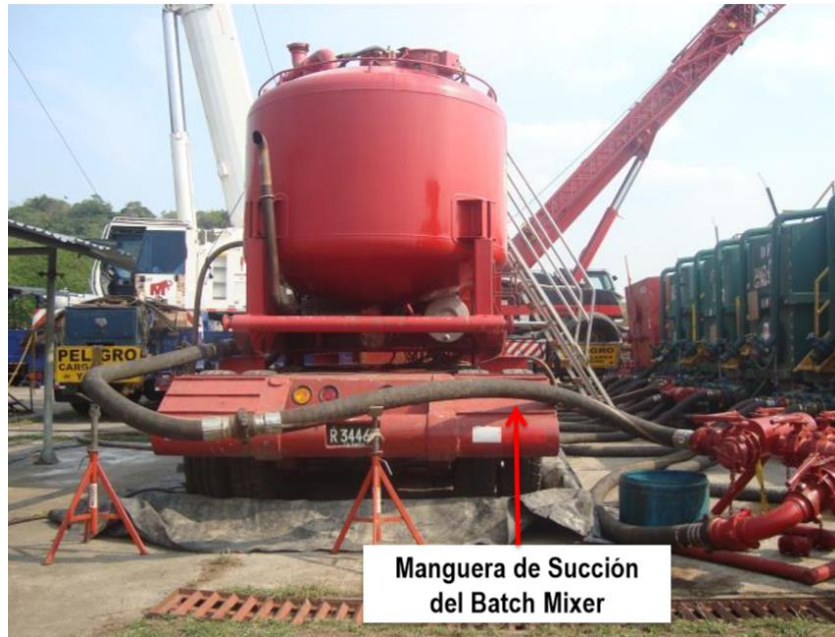
Figura 50. Elevación de las mangueras de succión que salen de la bomba
