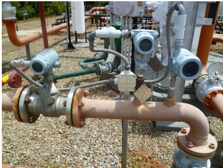
Figura 18. Medidor tipo Vortex descarga compresor de anulares, batería Monal
