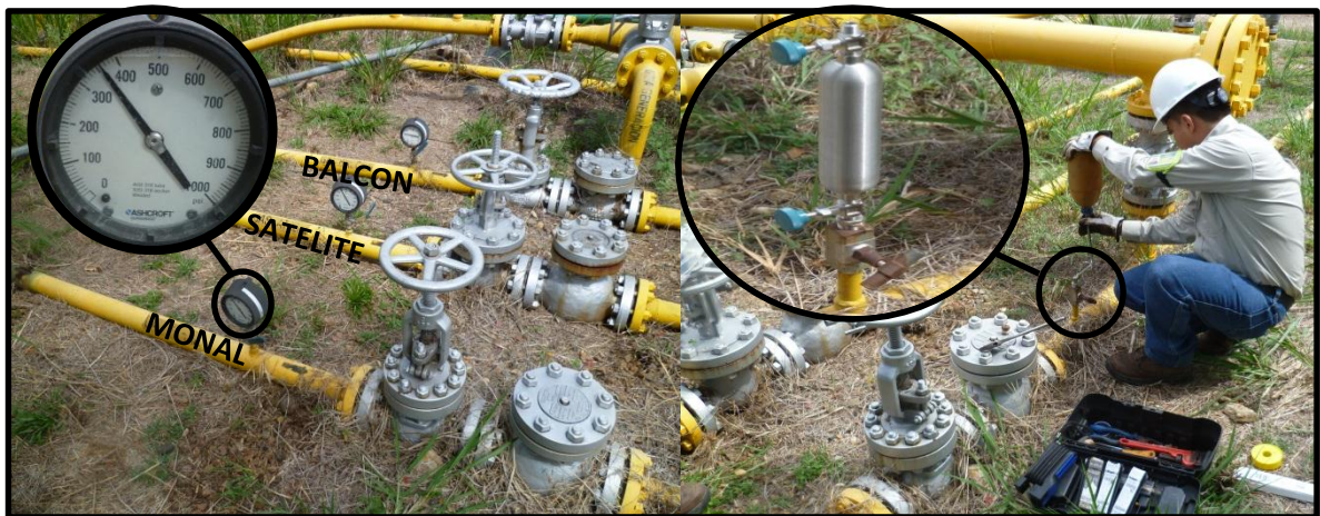
Figura 24. Toma de muestras línea de gas Monal, Satélite y Balcón
