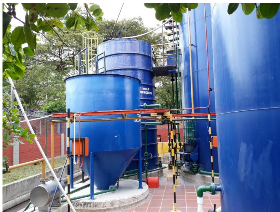
Fotografía 2 Infraestructura para el proceso de decantación y purificación
