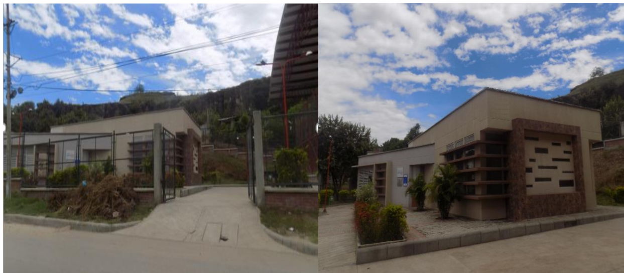
Figura 30. Entrada Parque Biblioteca y Auditorio o Biblioteca del Parque Mirador del Sur.
